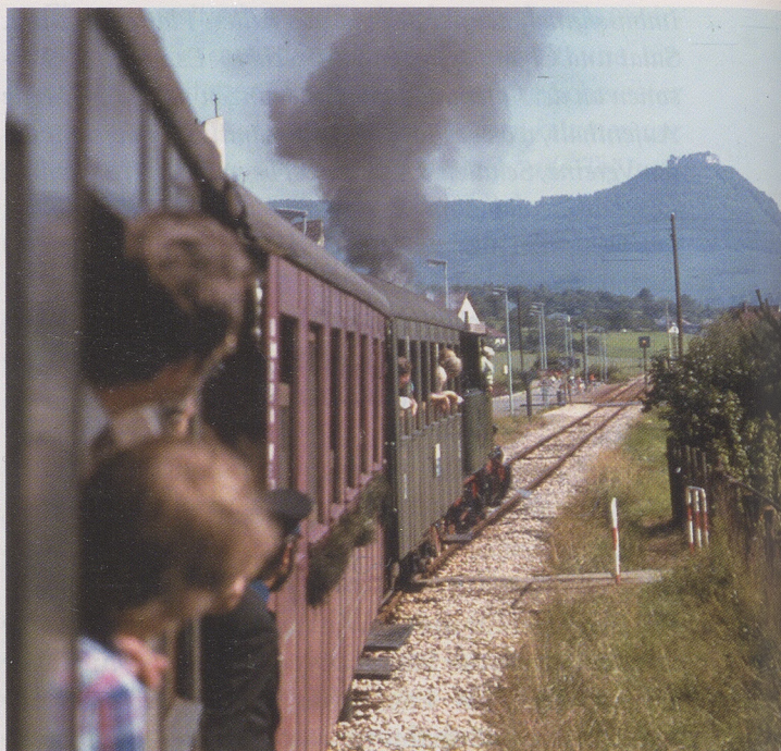
Mit dem «Sofazügler» der Gesellschaft zur Erhaltung von Schienenfahrzeugen ist die Dampflok ins «Täle» zurückgekehrt, hier die Lok 11 im Sommer 1978.
