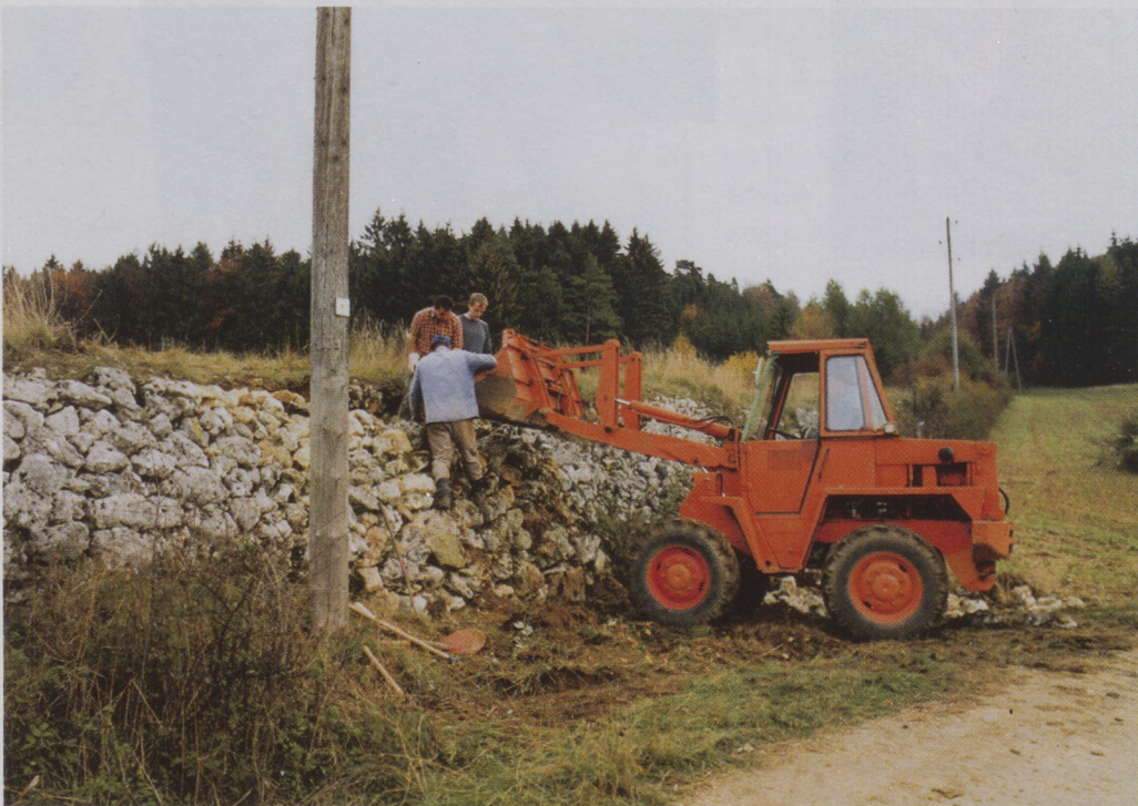
Eine der zahlreichen Aktivitäten des Vereins «Natur und Umwelt Veringen e. V.»: Trockenmauerbau an einer Wegböschung.
