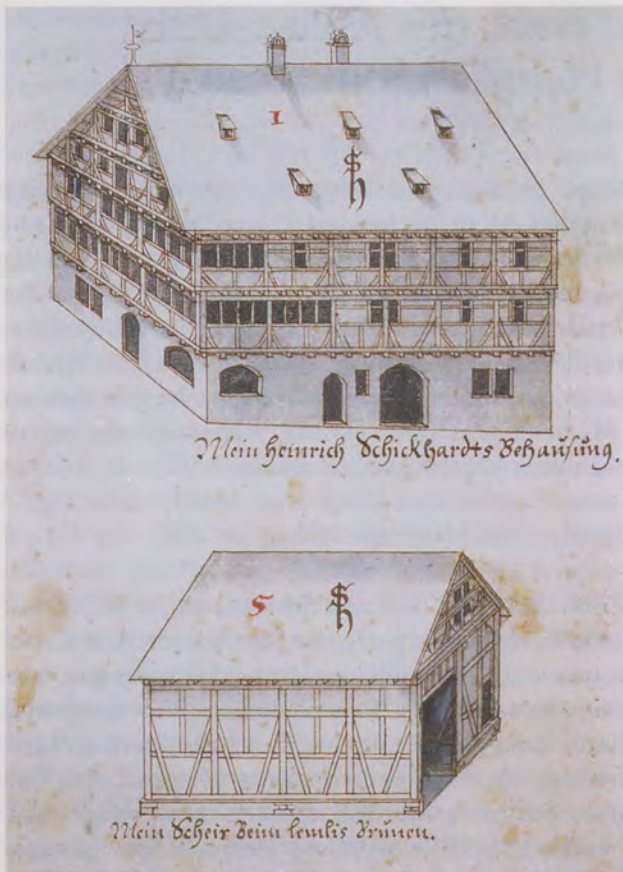
Schickhardts Haus samt Scheuer in Herrenberg.
