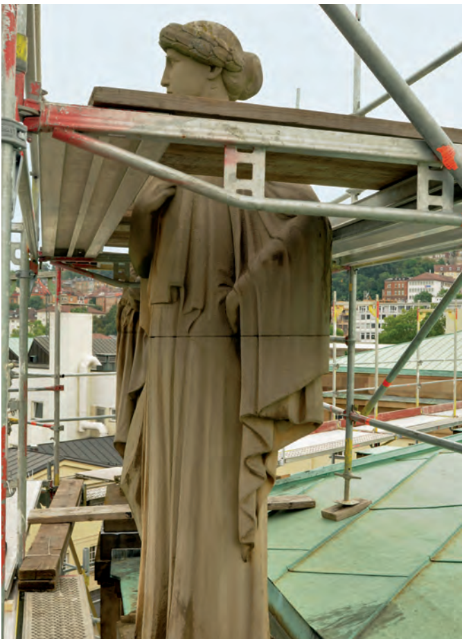
Die Personifikation der »Architektur« von Bildhauer Emil Kiemlen (hier während Konservierungsmaßnahmen 2016) steht nach dem Sturmschaden von Juni 2021 wieder zusammengefügt auf der Attika des Opernhauses.
