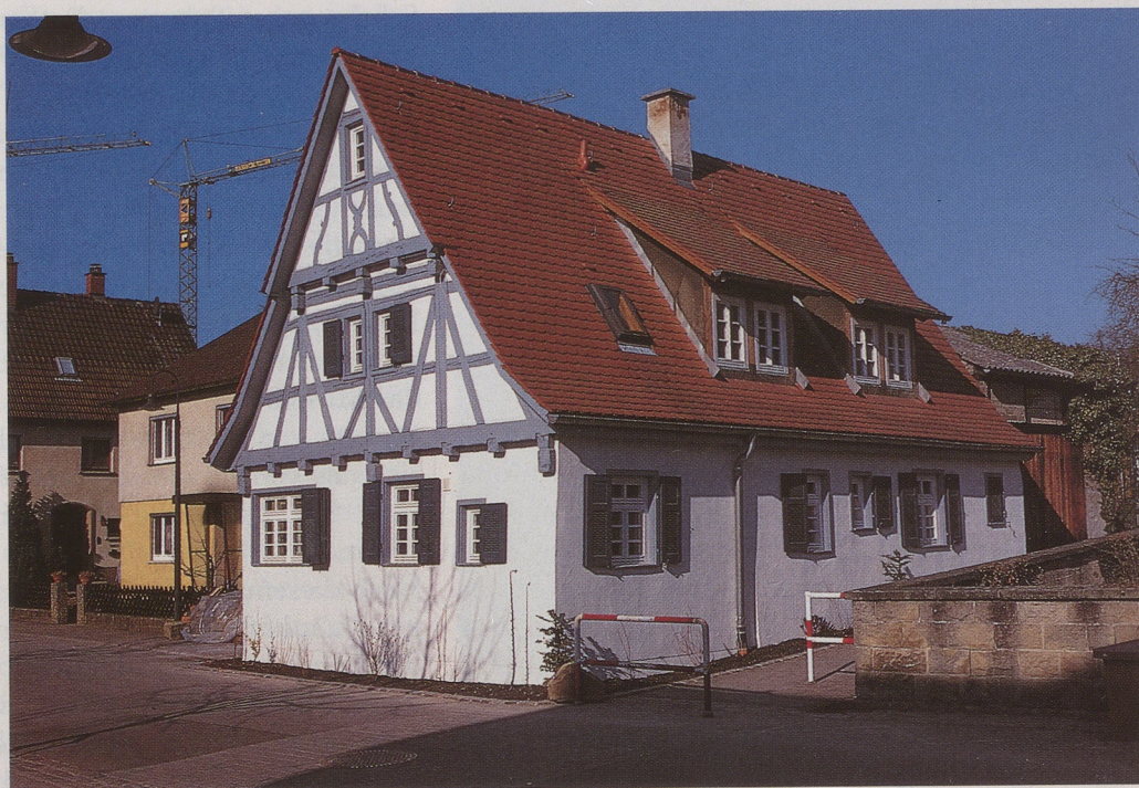
Das restaurierte ehemalige Seldner- haus, gleichfalls in Holzgerlingen.
