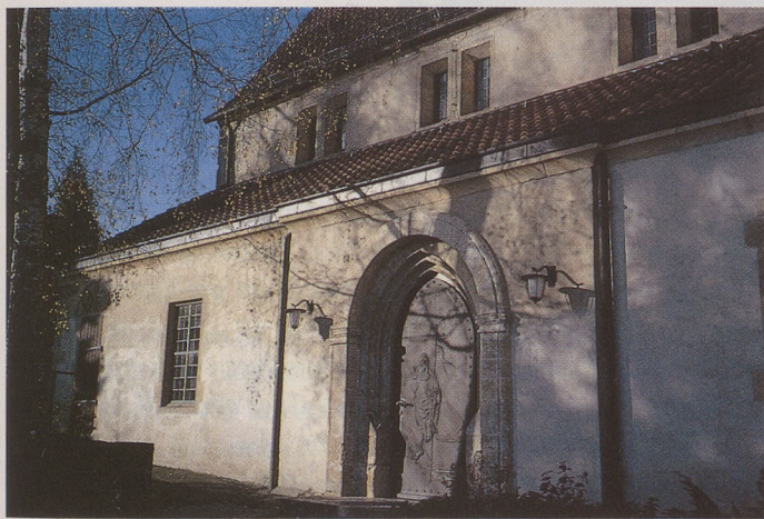
Romanisches Rundbogenportal und Schildmauer, heute auf der Südseite der Kirche. Viele Indizien deuten darauf hin, daß sie ursprünglich Teile eines Hauptportals an der Westfassade bildeten. Nachdem aber im Spätmittelalter der westliche Kirchhofbereich zwei Meter hoch aufgeschüttet wurde, mußte man den Haupteingang verlegen und setzte Bogen und Schildmauer vor den gotischen Südeingang.
