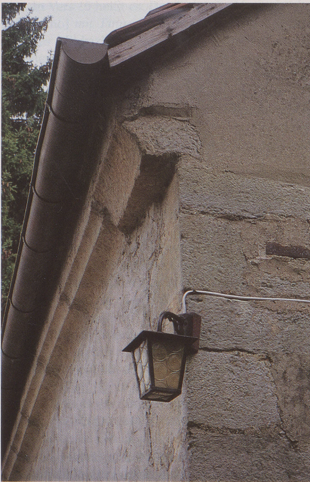
Dachgesimssteine an der Nordwestecke der Sakristei heute. Man sieht deutlich den Unterschied zwischen den gotischen, mehrfach gefalteten Mauerabschlußsteinen links und dem schlichten romanischen Hohlprofil rechts, das typisch für die romanischen Bauteile der Nikomedeskirche ist. Der romanische Mauerabschlußstein beweist, daß hier heute noch die Ostwand des Chors der «alten Hofkapelle» steht. Sie ist der Pfalzgrafenburg zuzuordnen, die 1165 von Welf VII. zerstört wurde.
