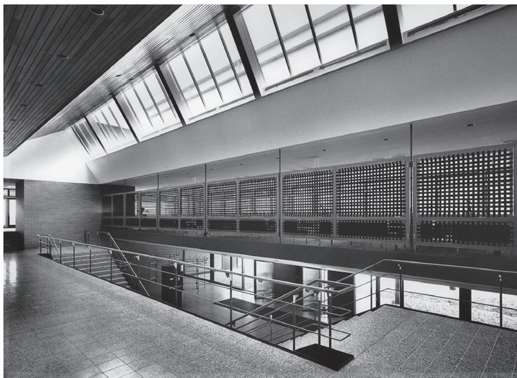
Das Casino setzte sich gestalterisch von den Pavillons ab, es ist niedriger und besitzt eine längliche Form. Auf dem Bild ist das Foyer der Kantine zu sehen, die für 850 Mittagspäusler ausgelegt war.
