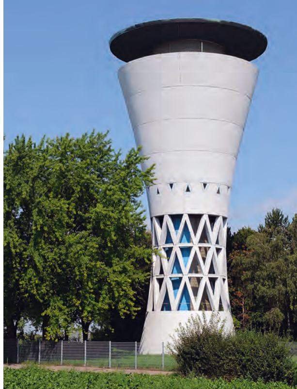
Eine moderne Landmarke mit kompliziertem Namen: die Rotationshyperboloid-Konstruktion des Möglinger Wasserturms. 1962–1965, R. Kessler, F. Cenek, L. Bauer.
