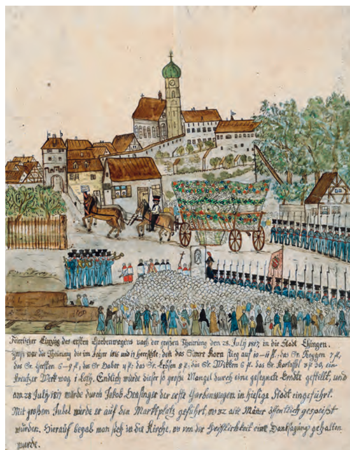
Die Not ist vorüber: «Feierlicher Einzug des ersten Garbenwagens nach der großen Theurung den 28. July 1817 in die Stadt Ehingen. Groß war die Theurung [...]. Endlich wurde dieser so große Mangel durch eine geseignete Erndte gestillt [...].»
