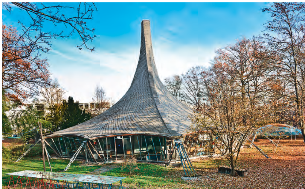
Vorbild fürs weltberühmte Münchener Olympiadach: Das Institut für leichte Flächentragwerke auf dem Stuttgarter Uni-Campus. 1967/68, Frei Otto.
