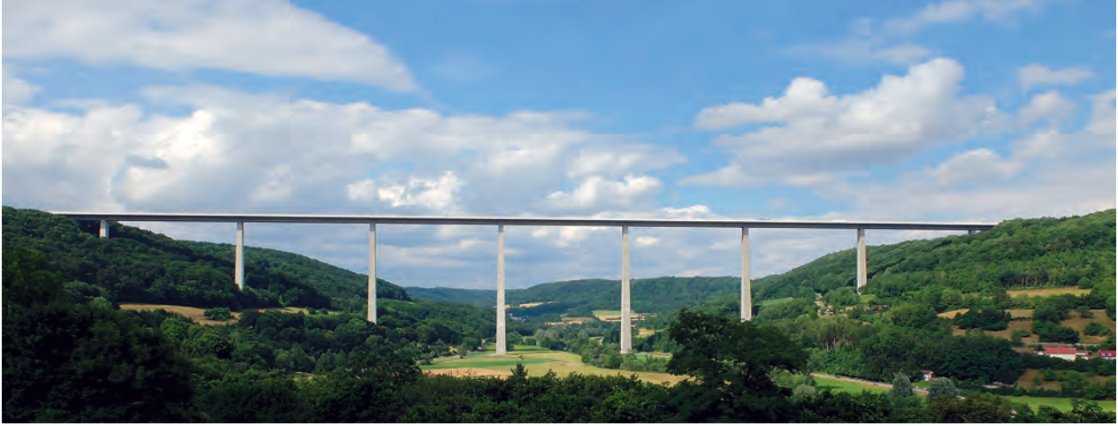
Kühner Meilenstein des Straßenbaus auf höchstem Niveau: die Kochertalbrücke bei Braunsbach. 1976–1979, Leonhardt, Andrä & Partner, H. Kammerer.
