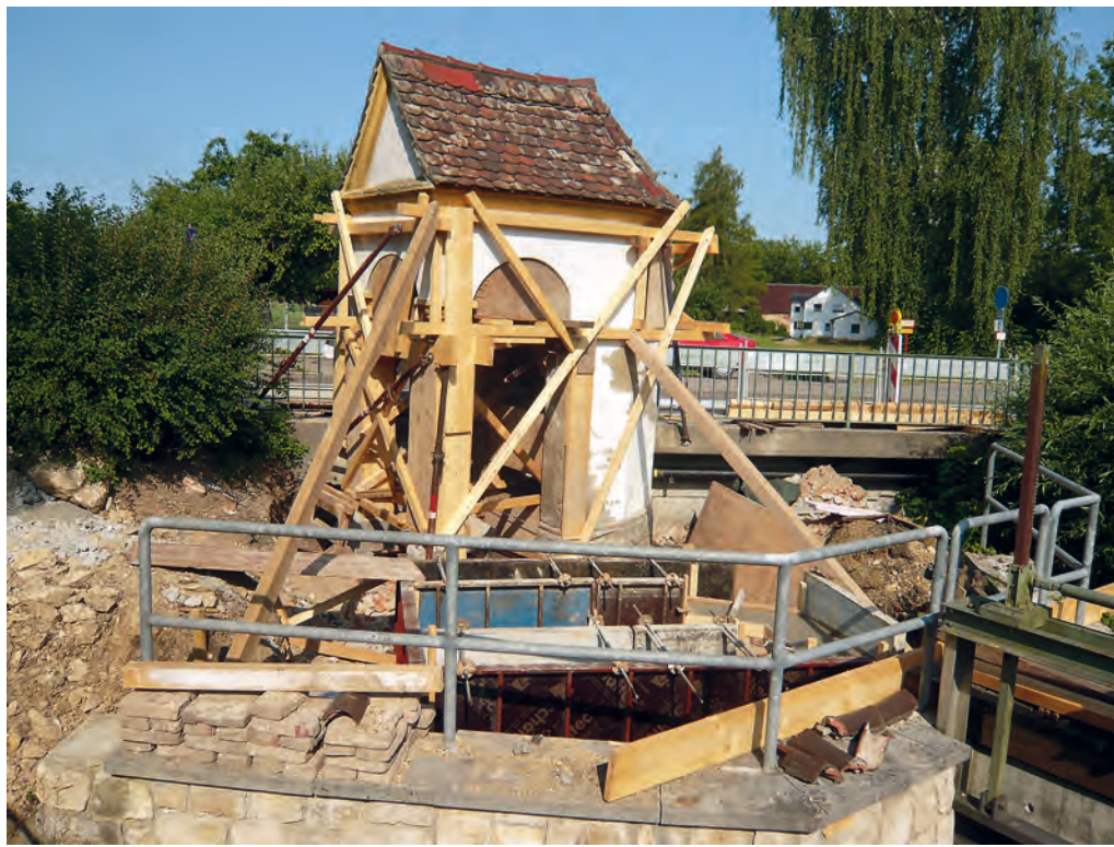
Eine logistische und handwerkliche Meisterleistung: die Versetzung und Sanierung der Wiblinger Nepomuk-Kapelle.
