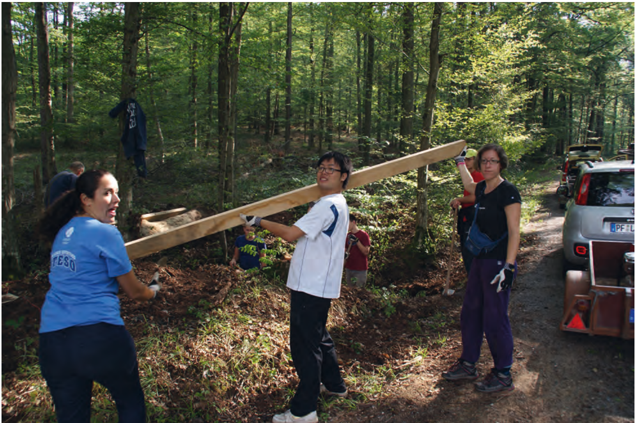
Mit dem Einbau großer Laubrechen in die Gräben lässt es sich verhindern, dass an neuralgischen Punkten im Grabenverlauf Verstopfungen und Überschwemmungen auftreten.
