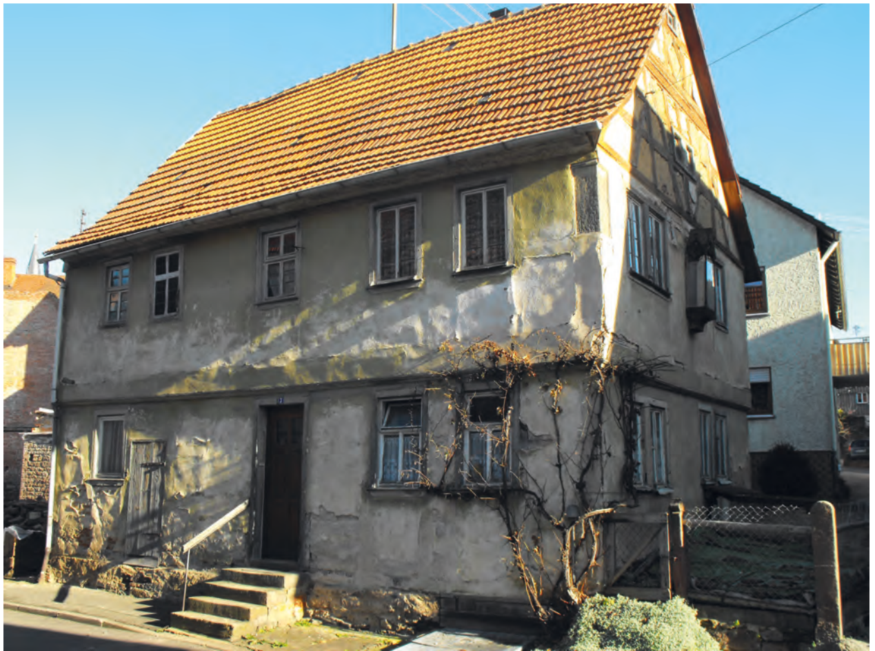
Ein sicherer Abbruchkandidat – so schien es, bevor Harald Brode sich des kleinen Fachwerkhauses in Kilsheim annahm.
