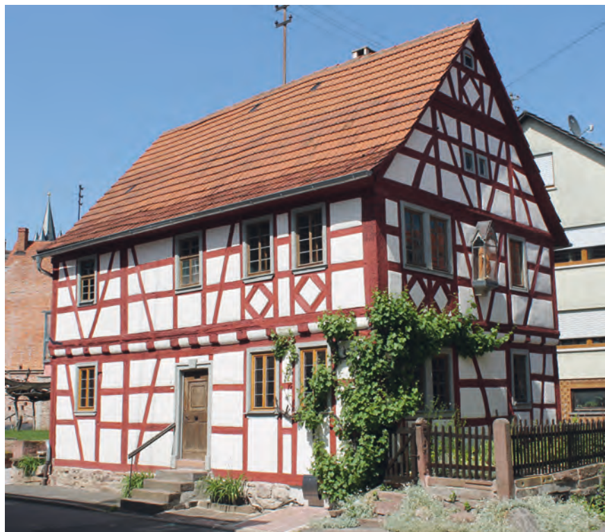
Das von Harald Brode gerettete Fachwerkhaus wurde wieder in ein ansehnliches Schmuckstück im Ortsbild von Kilsheim verwandelt.
