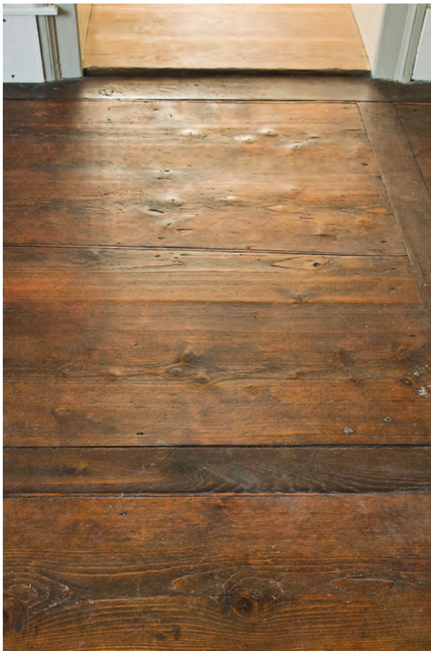
Die lebendigen Oberflächen der freigelegten und restaurierten Dielenböden.
