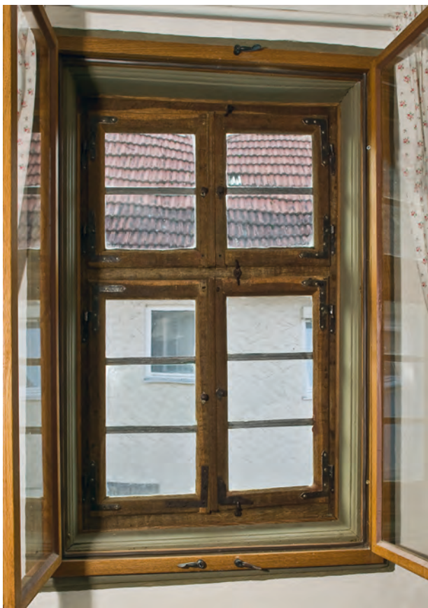
Die sorgfältig restaurierten historischen Fenster wurden für eine bessere Energiebilanz mit zusätzlichen Innenfestern ergänzt.
