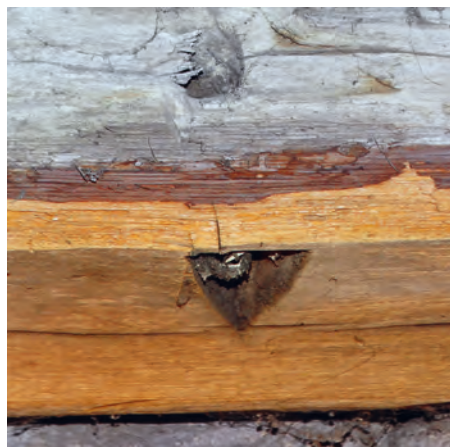
Bild links: Wiedlöcher am Ende einer Strebe im Dachwerk der Stadtkirche in Vaihingen/Enz (1697–1701). Mitte: Geflößte Eiche mit Wiedloch im mittelalterlichen Turm der Stadtkirche Bönningheim. Bild rechts: Bohrlochpaar mit abgeschlagenen Resten der Holznägel an einem Kehlbalken in dendrochronologisch auf 1544 datierten Dachwerk von Schloss Großsachsenheim.
