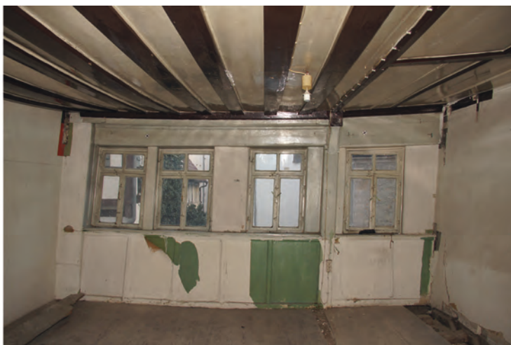
Links: Blick in die Bohlenstube im Obergeschoss von Oberamteistraße 32 mit der gewölbten Bohlenbalkendecke aus der Bauzeit von 1320. Rechts: Blick in die neuzeitliche Stube im Obergeschoss des Hausteils Oberamteistraße 30 mit Bretterbalkendecke des 17./18. Jahrhunderts und Täferdecke im Bereich des ehemaligen Alkovens (Schlafkammer), der wie das Brüstungstäfer und einzelne Fenster einem Umbau um 1800 zuzuweisen ist.
