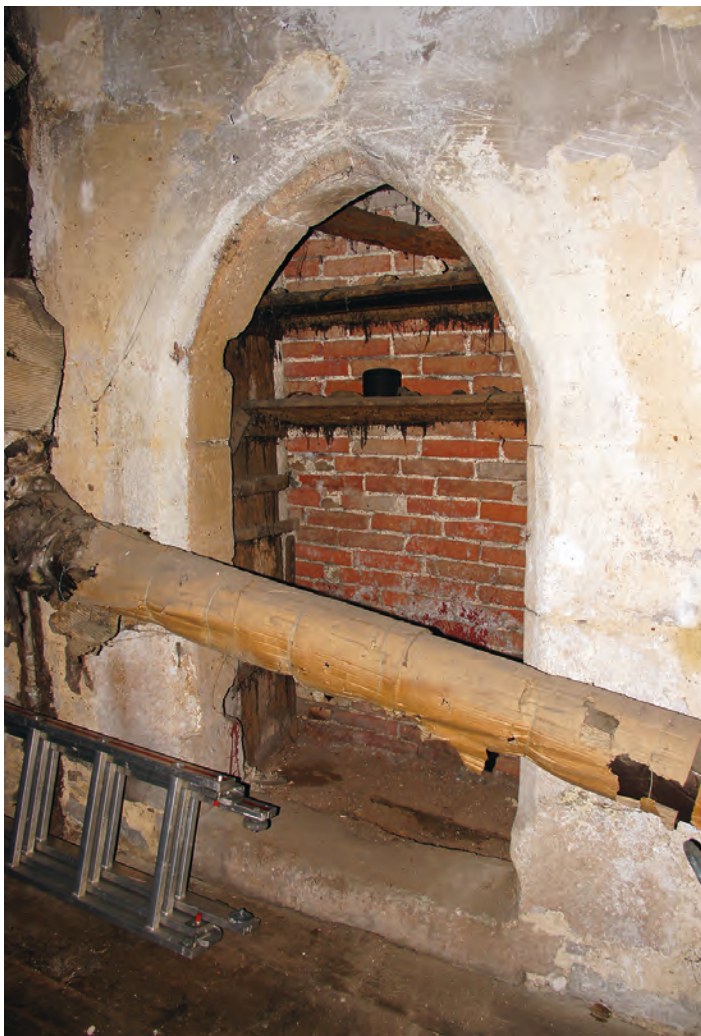
Spitzbogenportal in der Brandwand zwischen Oberamteistraße 30/32 und Nr. 28: ursprünglicher Hauseingang zum 1316/17 errichteten, 1354 jedoch grundlegend um- oder neugebauten Fachwerkhaus Oberamteistraße 28.
