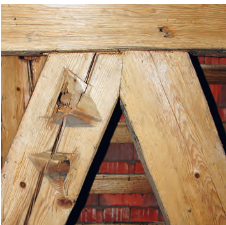
Bild links: Wiedlöcher am Ende einer Strebe im Dachwerk der Stadtkirche in Vaihingen/Enz (1697–1701). Mitte: Geflößte Eiche mit Wiedloch im mittelalterlichen Turm der Stadtkirche Bönningheim. Bild rechts: Bohrlochpaar mit abgeschlagenen Resten der Holznägel an einem Kehlbalken in dendrochronologisch auf 1544 datierten Dachwerk von Schloss Großsachsenheim.
