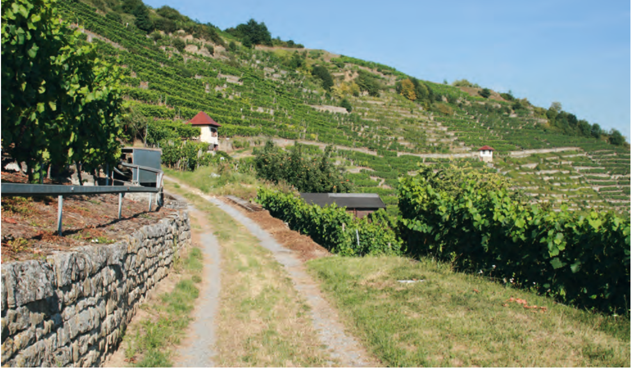
Die Rosswager Halde. 23 Kilometer Trockenmauern, 30.000 Quadratmeter Maueransichtsfläche, 1.400 Arbeitsstunden pro Hektar und Jahr für die Wengertler. Eine Plackerei, jedoch wunderschön zum Ansehen und dazu noch schmackhaft.
