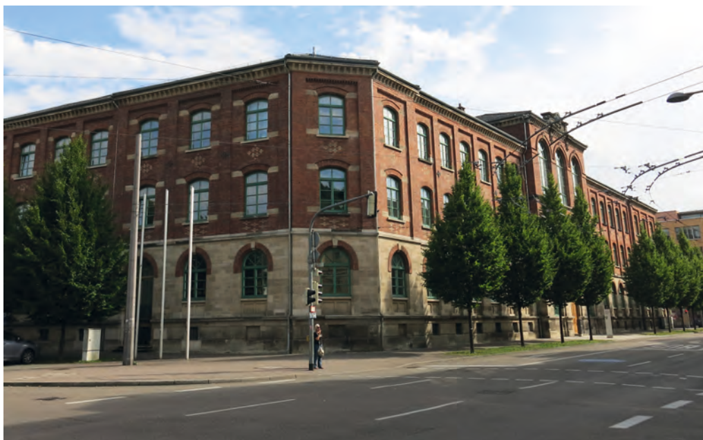
Landesamt für Denkmalpflege Baden-Württemberg in Esslingen am Neckar, vormals städtische Realan- stalt. Hauptfront nach Westen mit Portal zur Berliner Straße, vormals Friedrichstraße; Seitenflügel nach Norden zur Schelztorstraße.
