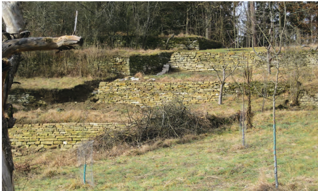
... entstand am Wendelsheimer Pfaffenberg in Handarbeit wieder Kulturlandschaft mit eindrucksvollen Trockenmauern.
