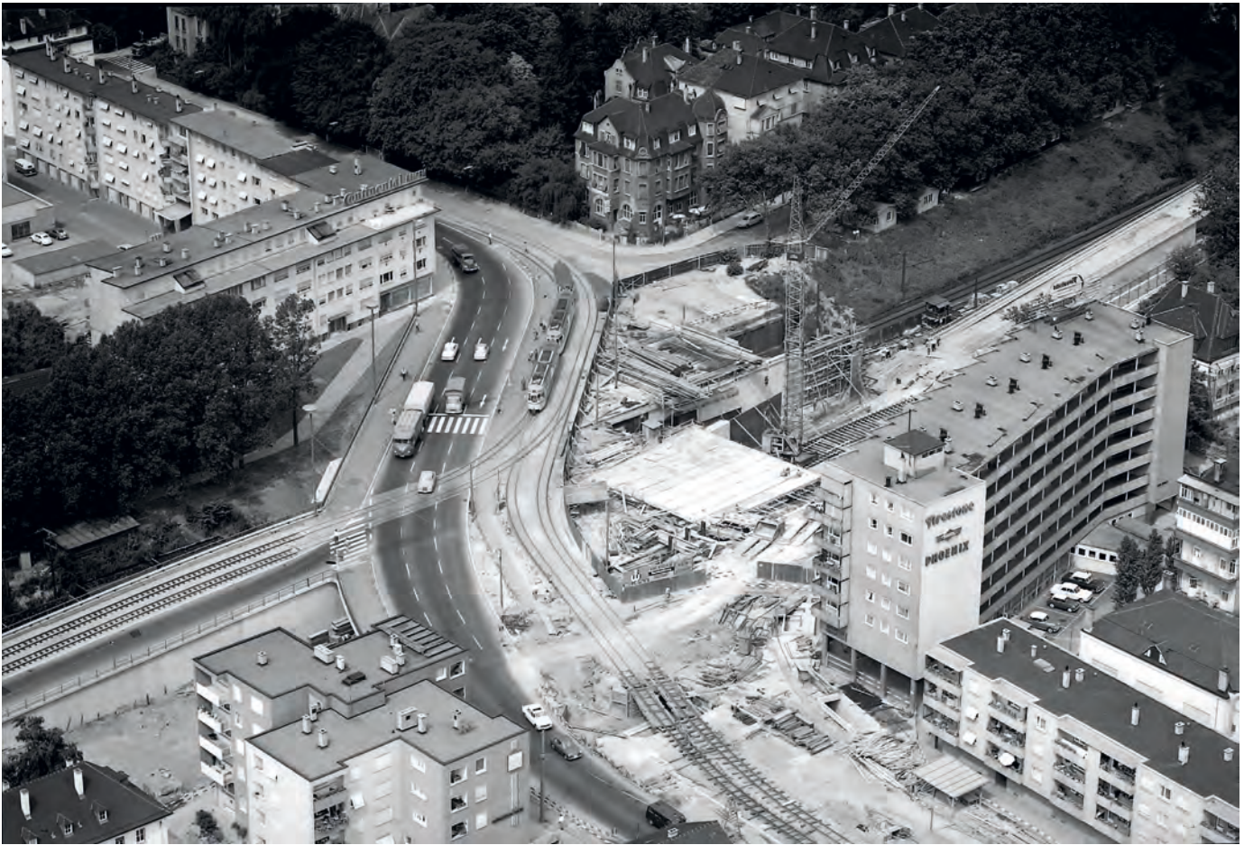
Luftaufnahme des im Bau befindlichen, damals größten Verkehrsbauwerks in Stuttgart am Augsburgplatz, 1964
