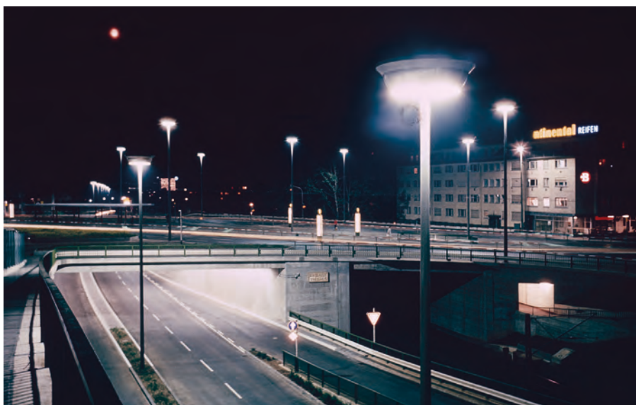
Das Verkehrsbauwerk Augsburgener Platz bei Nacht in den ersten Jahren nach seiner Fertigstellung
