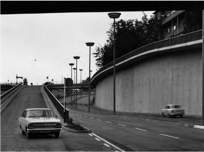
Abfahrtsrampe von der neuen Brücke an der Wiesbadener Straße und ausgebauter Gnesener Straße
