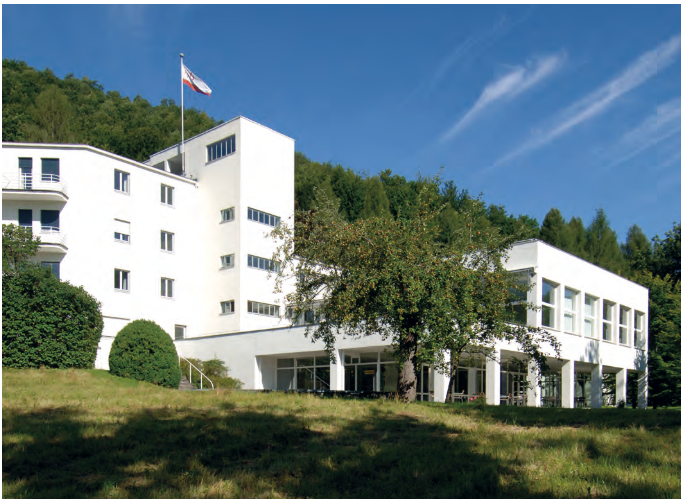
Das »Haus auf der Alb« in Bad Urach wurde als Kaufmannserholungsheim entworfen und 1930 eingeweiht. Nach grundlegender Sanierung dient es seit 1992 der Landeszentrale für politische Bildung als Tagungszentrum.
