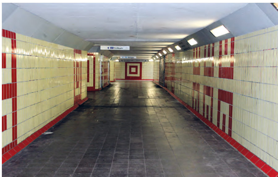
Fußgängerunterführung unter der Straßenbahninsel (heutiger Zustand)
