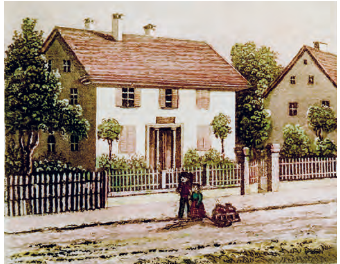
Das 1851 erbaute Krankenhaus der Güterkaufgesellschaft diente der Krankenpflege der Korntaler. Das Gebäude existiert nicht mehr.
