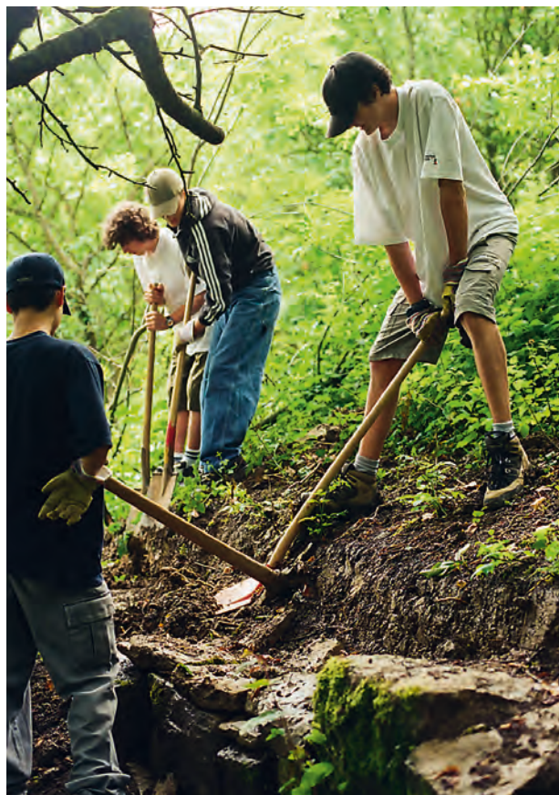
Helmut Mager aus Vaihingen hat das Talent, seine Begeisterung für die Landschaftspflege an Jugendliche weiterzugeben – hier beim Bau einer Trockenmauer in Kleiningersheim.
