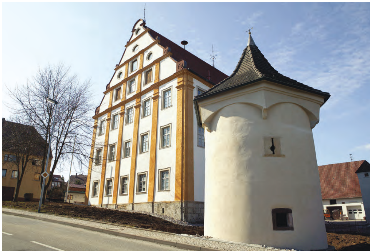
An den Vorgängerbau aus dem 16. Jahrhundert erinnern noch der Gewölbekeller, über dem der barocke Neubau errichtet worden ist, und einer von ursprünglich vier Wehrtürmen.
