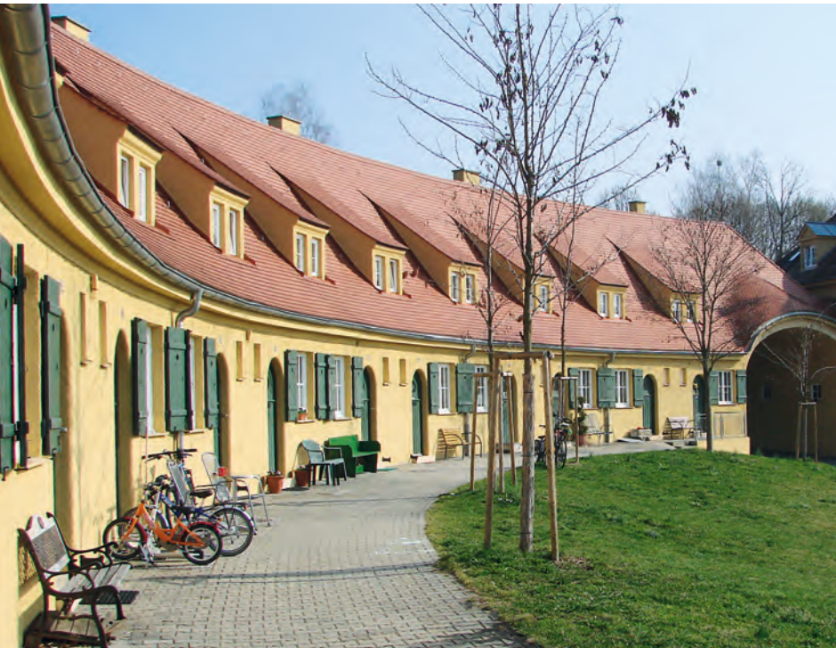
Abbildung links: Bruno Taut hat mitgebaut: Der halbrunde Altenhof, Krönung der Arbeitersiedlung Gmindersdorf.
