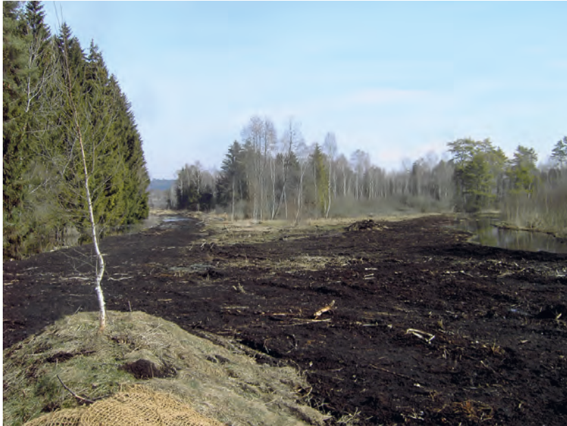
Die «Oberen Schnöden» nach den Wiedervernässungsmaßnahmen, links das ehemalige Tiefenbachgerinne, rechts das neue Tiefenbachgerinne.
