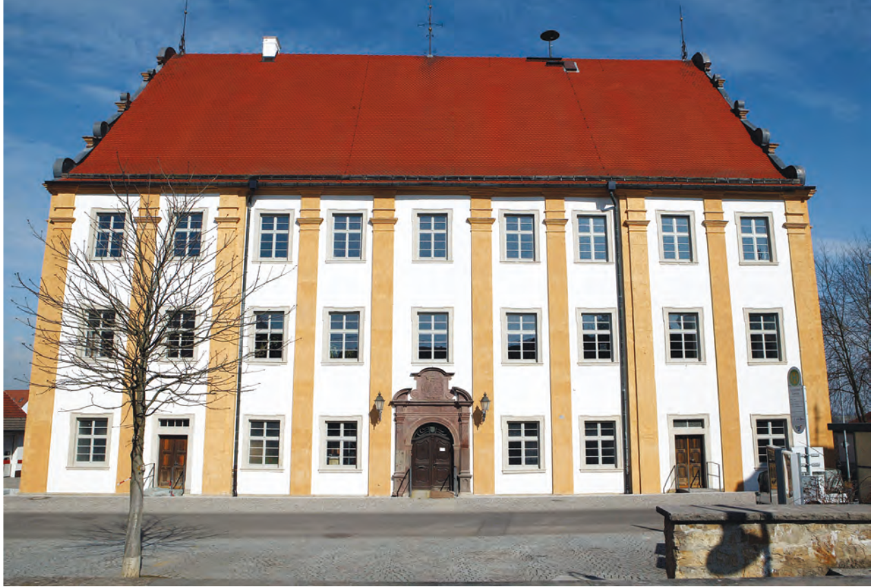
Das Nordstetter Schloss ist mit 27 Meter Höhe ein weit in die Landschaft wirkendes Bauwerk, dessen Südfassade durch geschossübergreifende Lisenen in neun Achsen gegliedert wird.
