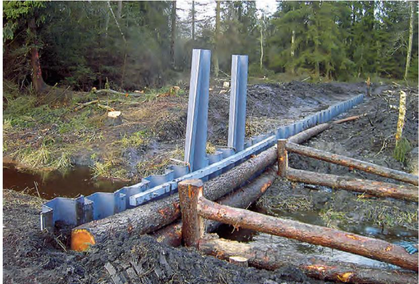
*Teilweise fertiggestelltes Spundwandwehr im Tiefenbach zur Ausleitung des Wassers in die Oberen Schnöden.*
