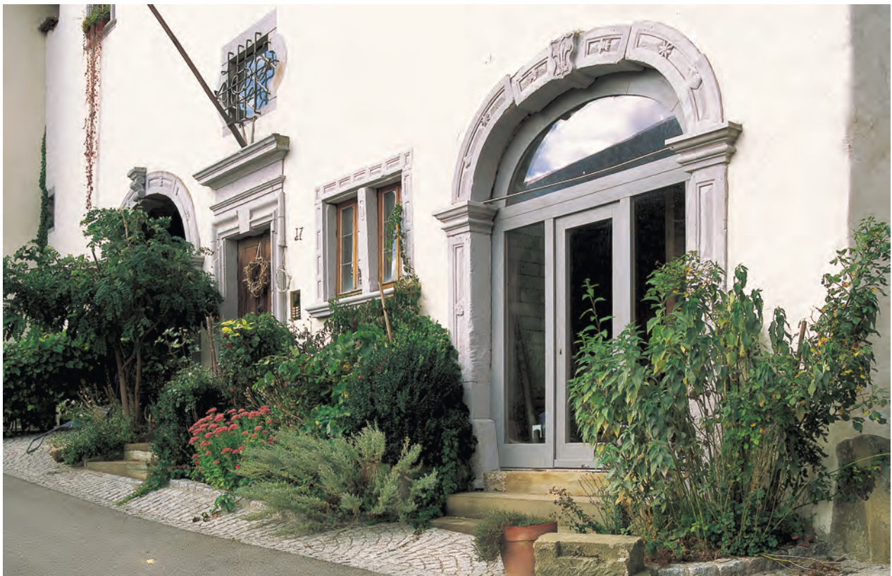
In der Außenmauer des Hauptbaus zeugen Gewände aus Renaissance und Barock von einer wechselvollen Baugeschichte des Oberen Schlosses.
