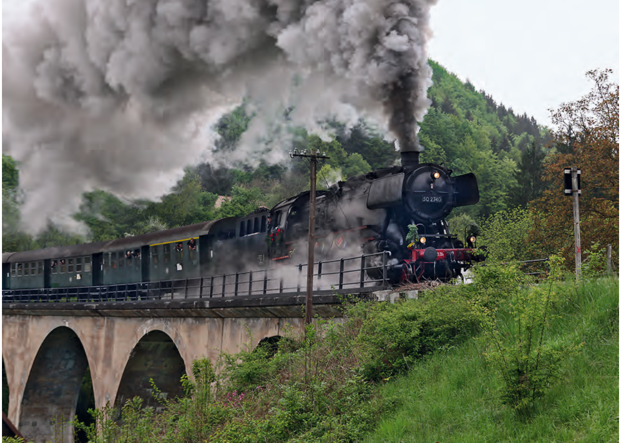
Der Bergbahncharakter wird besonders deutlich beim Strümpfelbach-Viadukt.
