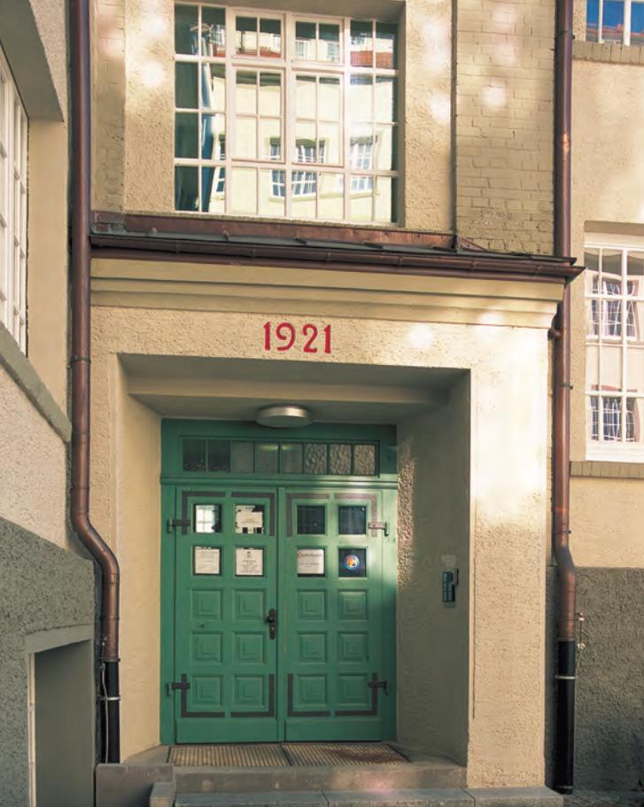
Vorbildlich restauriert in den Details – der Trossinger Fabrikbau mit originalen Türen und Fenstern.
