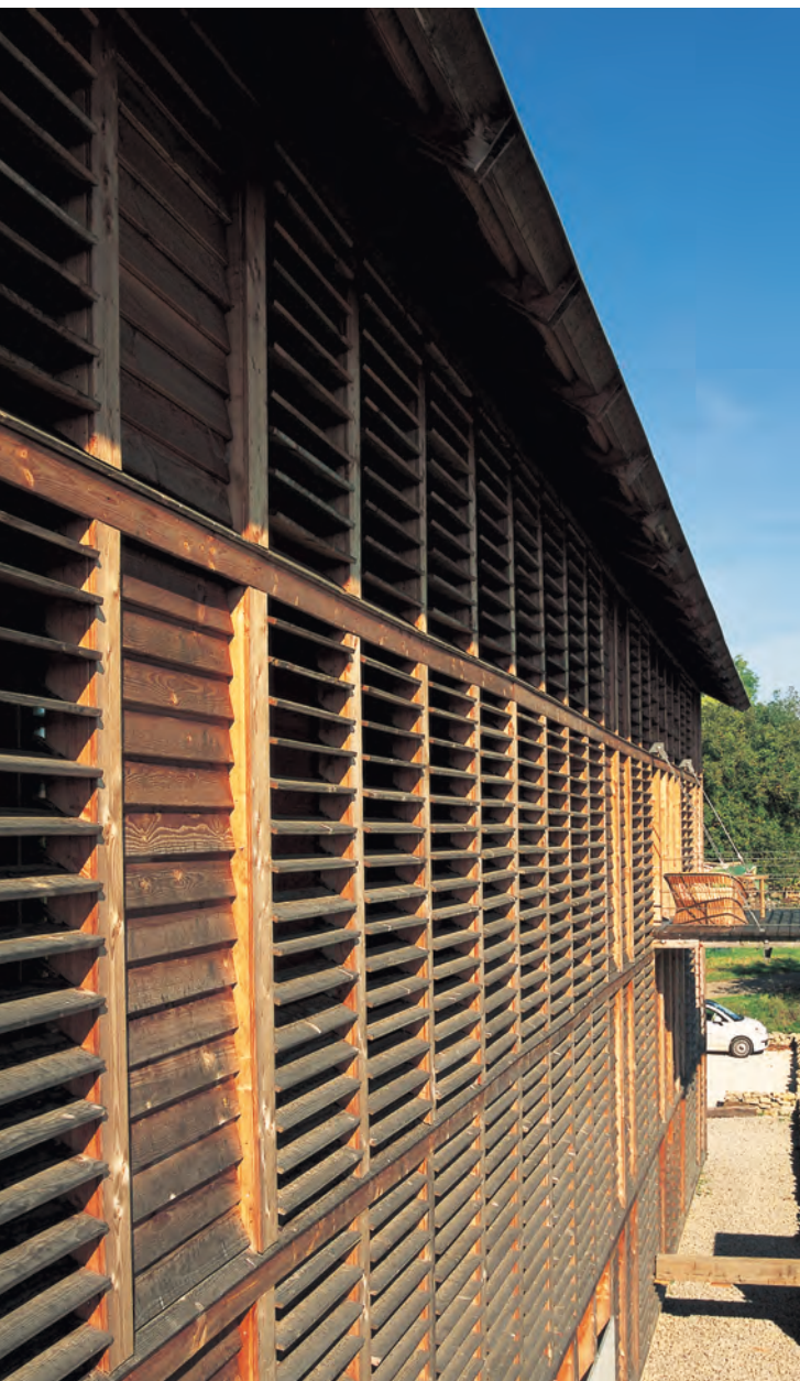
Die charakteristische Außenhaut des Tabakschuppens mit ihren verstellbaren Lamellen nach der Erneuerung.
