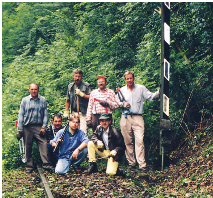
Oben: So sah die Bahntrasse zu Beginn der Streckenarbeiten fast überall aus.
