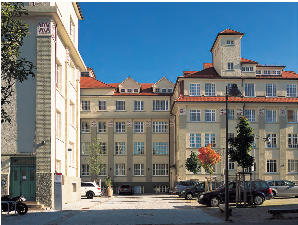
Der Bau V der früheren Hohner-Werke in Trossingen von Philipp Jakob Manz ist nach der Sanierung wieder ein ansehnliches Industriedenkmal und gleichzeitig ein Ort urbanen Lebens geworden.
