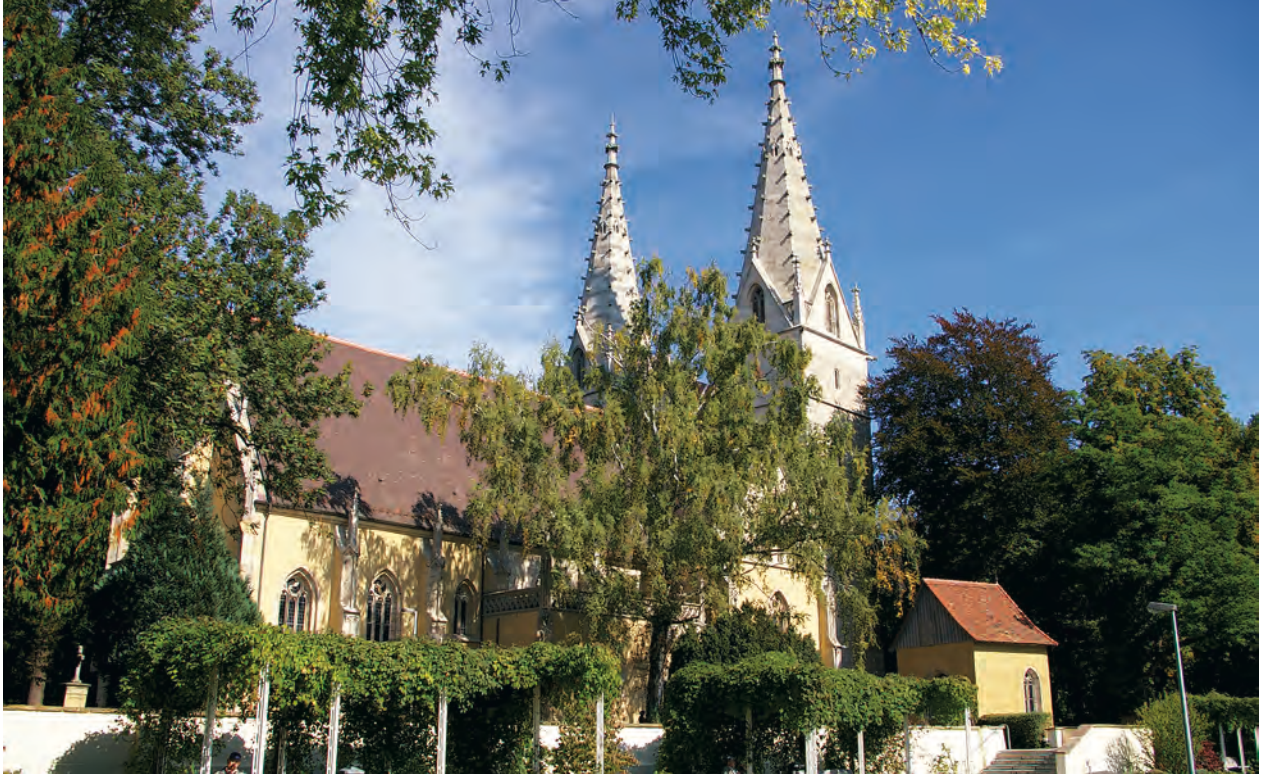
Die gotische Oberhofenkirche in Göppingen nach der grundlegenden Renovation. Rechts daneben die Heilig-Kreuz-Kapelle, das älteste Bauwerk der Stadt im Filstal.
