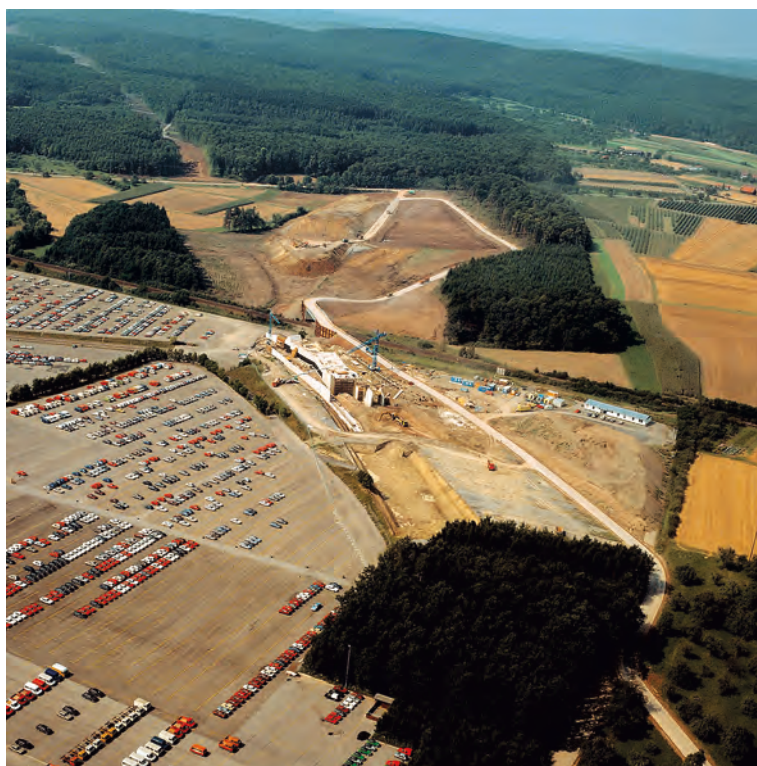
Ausmaß des Landschaftsverbrauchs durch den Bau der ICE-Schnellbahntrasse bei Illingen, 1988.
