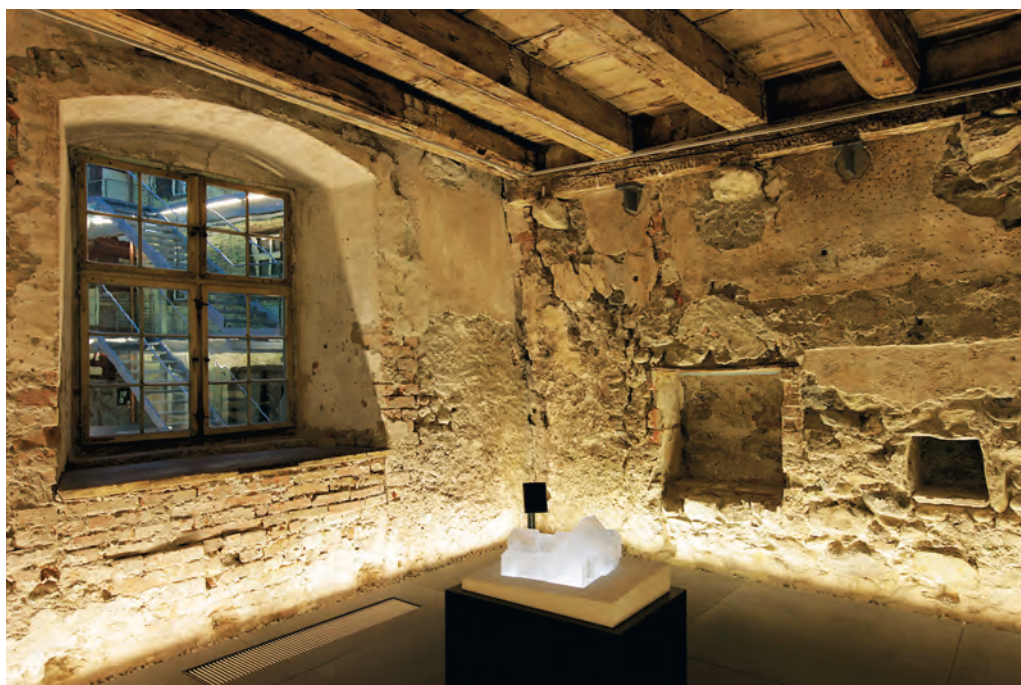
In diesem Raum im Erdgeschoss des Gebäudes Marktstraße 45 sind historische Schichten aus sieben Jahrhunderten Quartierge-schichte ablesbar.
