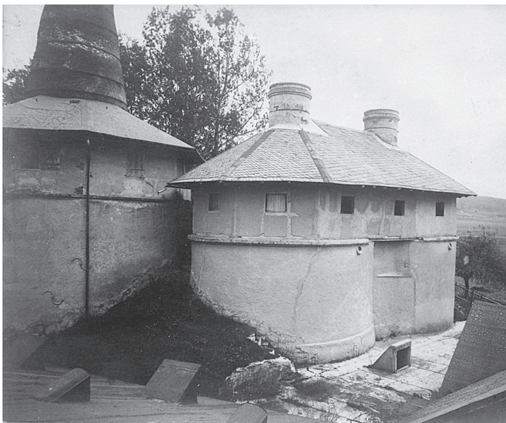
Leistungsfähige, kontinuierlich arbeitende Schachtöfen, erbaut im Jahr 1882.
