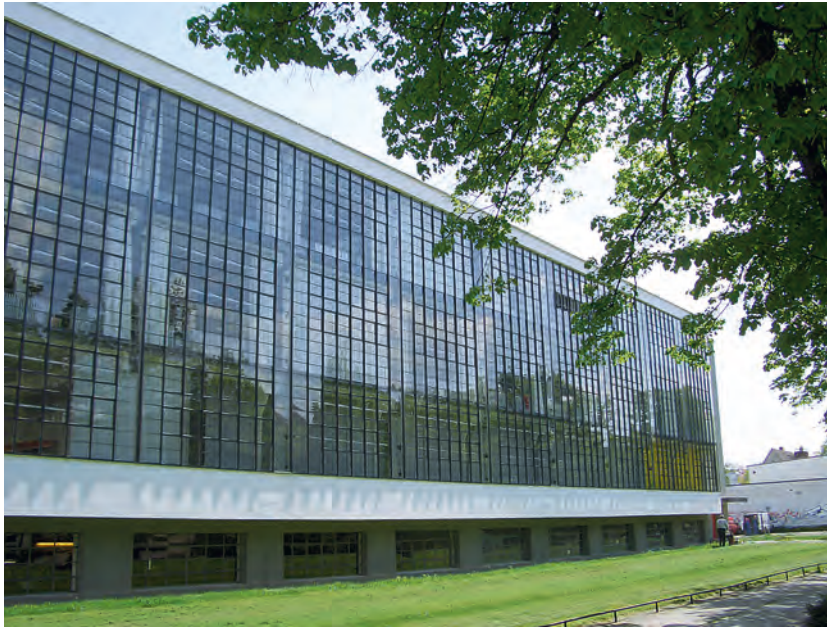
Bauhaus Dessau, Werkstatttrakt, 1926 errichtet von Walter Gropius. Inbegriff des Neuen Bauens.
