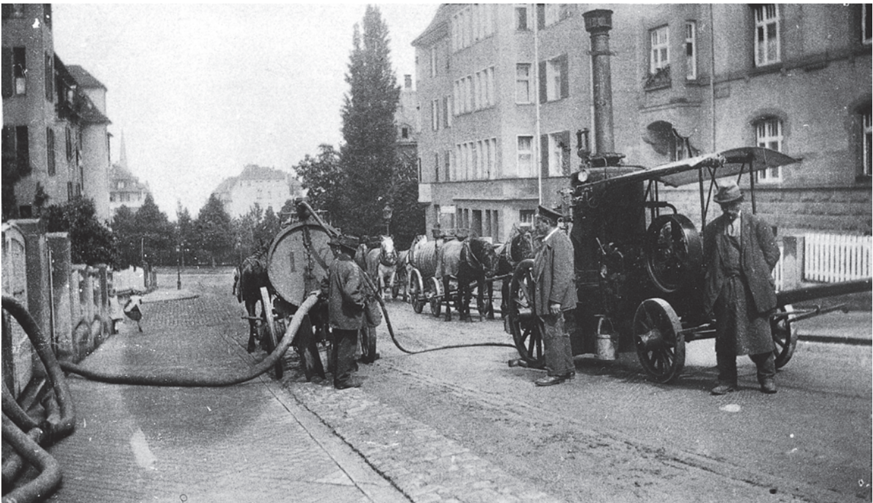
Die Stuttgarter «Schlauchartillerie» bei der Arbeit, zirka 1925: Die Fäkaliengruben werden geleert und dann mit pferdegezogenen Wagen zu den Verladestellen am Nordbahnhof und am Westbahnhof gebracht.
