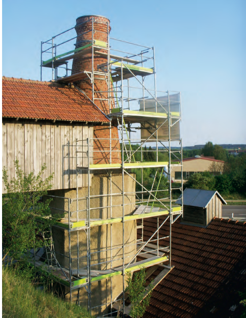
Zur Sanierung des gemauerten Kamins ist der Kalkofen Untermarchtal eingerüstet.
