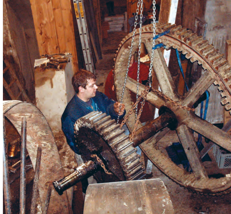
Viele Teile der Waldachtaler Mönchhofmühle mussten grundlegend überholt und saniert werden.
