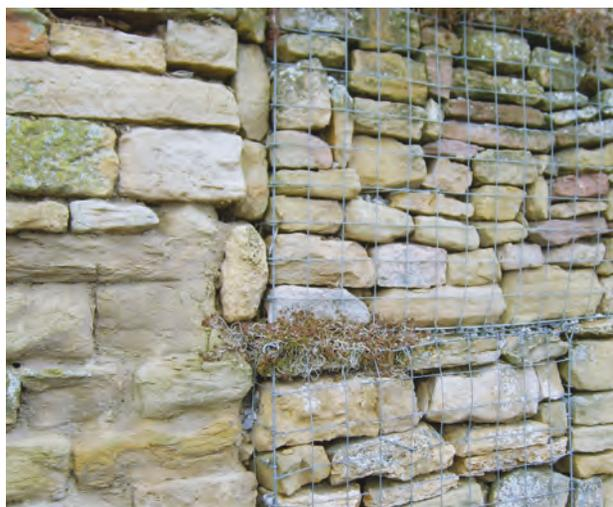
*Flickwerk in Weinbergmauern: «Gabionen», so genannte Drahtschotterkörbe, entsprechen nicht der ursprünglichen Anlage.*
