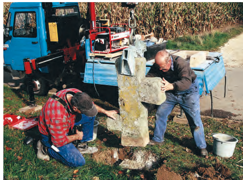
Beim Friedhof von Köngen, Landkreis Esslingen, stehen an der Böschung zwei Steinkreuze. Eines fällt besonders auf, denn die Kreuzarme sind in unterschiedlicher Höhe. Nachdem im Frühjahr 2004 das Kreuz aus Sandstein abgebrochen war, reparierte es Steinmetz Dieter Zimmermann im Auftrag der Gemeinde.
