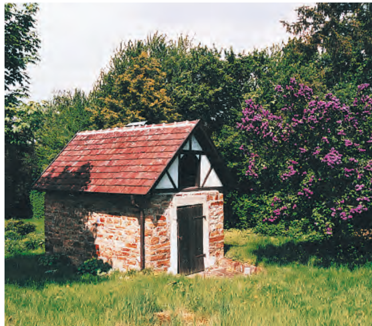
Zweimal dasselbe Häuschen: unten links vor der Restaurierung und von einer Werbetafel bedrängt, oben danach.
