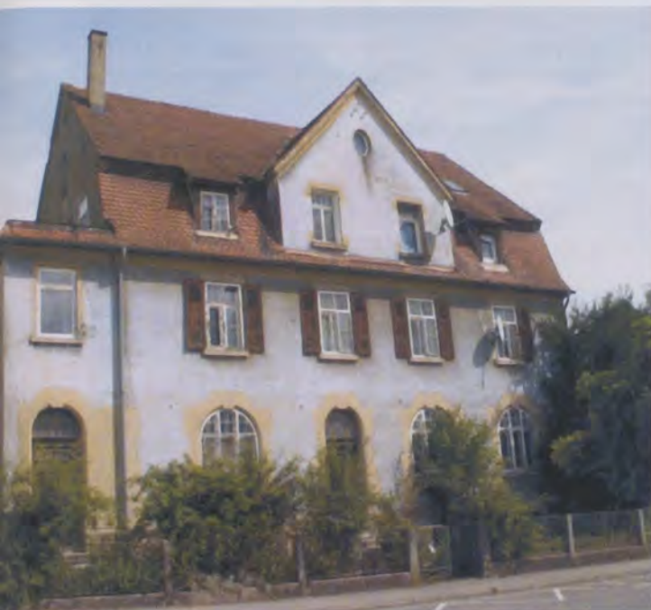
Das «Pädagogium» in Mögglingen auf der Ostalb ist ein eingetragenes Kulturdenkmal und benötigt dringend Eigentümer, die bereit sind, es zu Wohnzwecken oder gewerblich zu nutzen.
