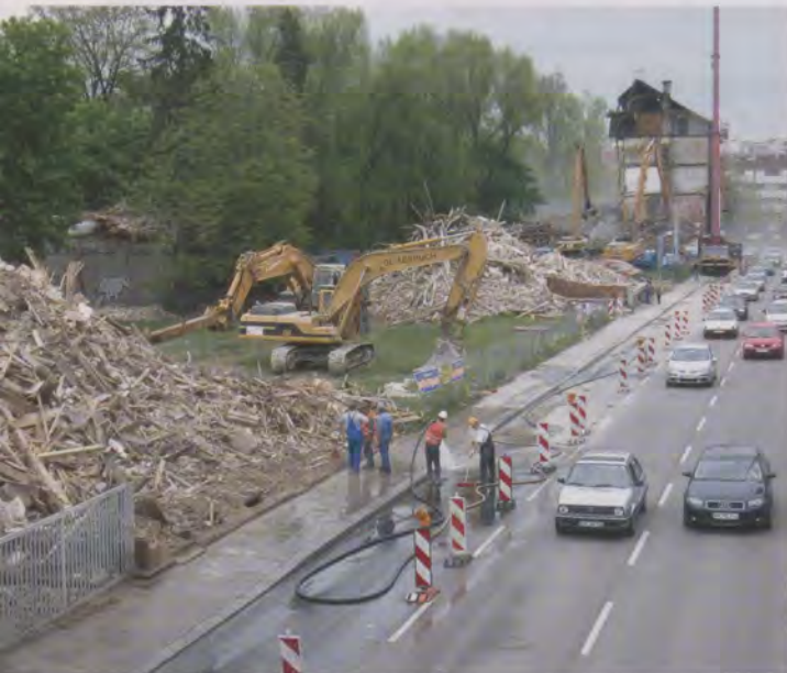
Die Bagger der Abbruchfirma haben an den denkmalgeschützten Gebäuden an der Willy-Brandt-Straße 31, 45, 47 und 57 unweit des Neckartors ihr Werk beinahe vollendet.
