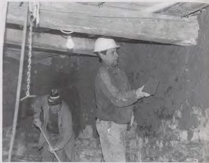
Neuer Lehmputz für die alten Mauern des Gerberhauses. Im Vordergrund Oberbürgermeister Paul Metzger.
