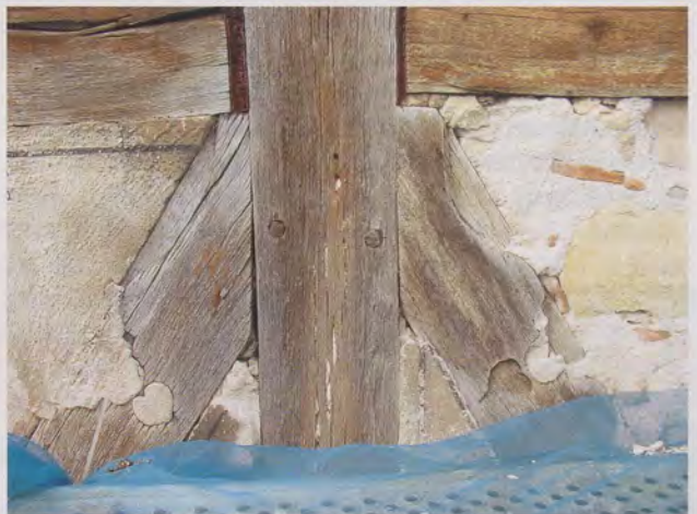
Fachwerkdetail im zweiten Obergeschoss dieses Hauses mit zusätzlich verzierten Fußstreben von 1612.
