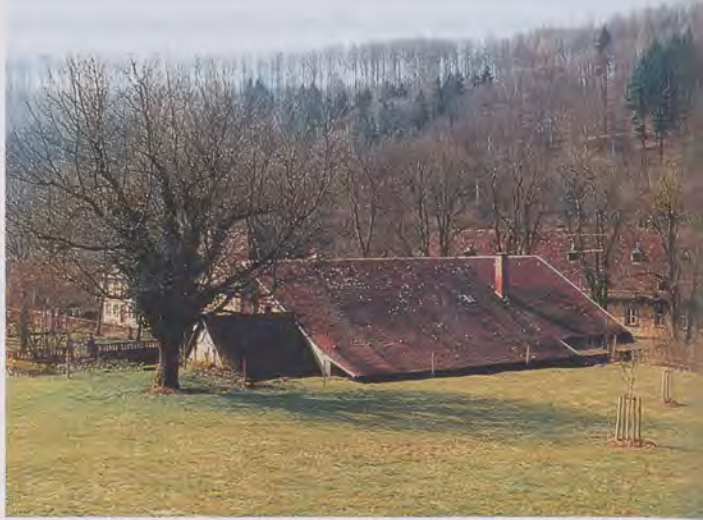
Die Bronnbacher Orangerie von Norden. Die Terrasse hinter dem Glashaus würde durch den Einbau des Küchentrakts «technisiert». Ein Lichthof mit Absturzsicherung, Lichtkuppeln und Lüftungskamine würden das Bild gravierend verändern. Rechts Bursariat, links Kirche und Abteigarten.
