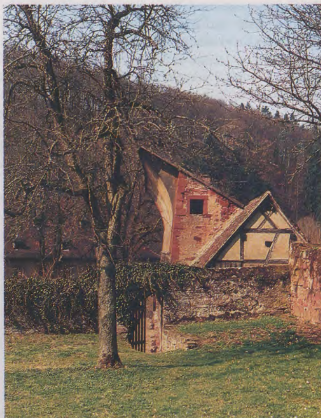
Westfassade der Bronnbacher Orangerie mit Frühbeetkästen.
