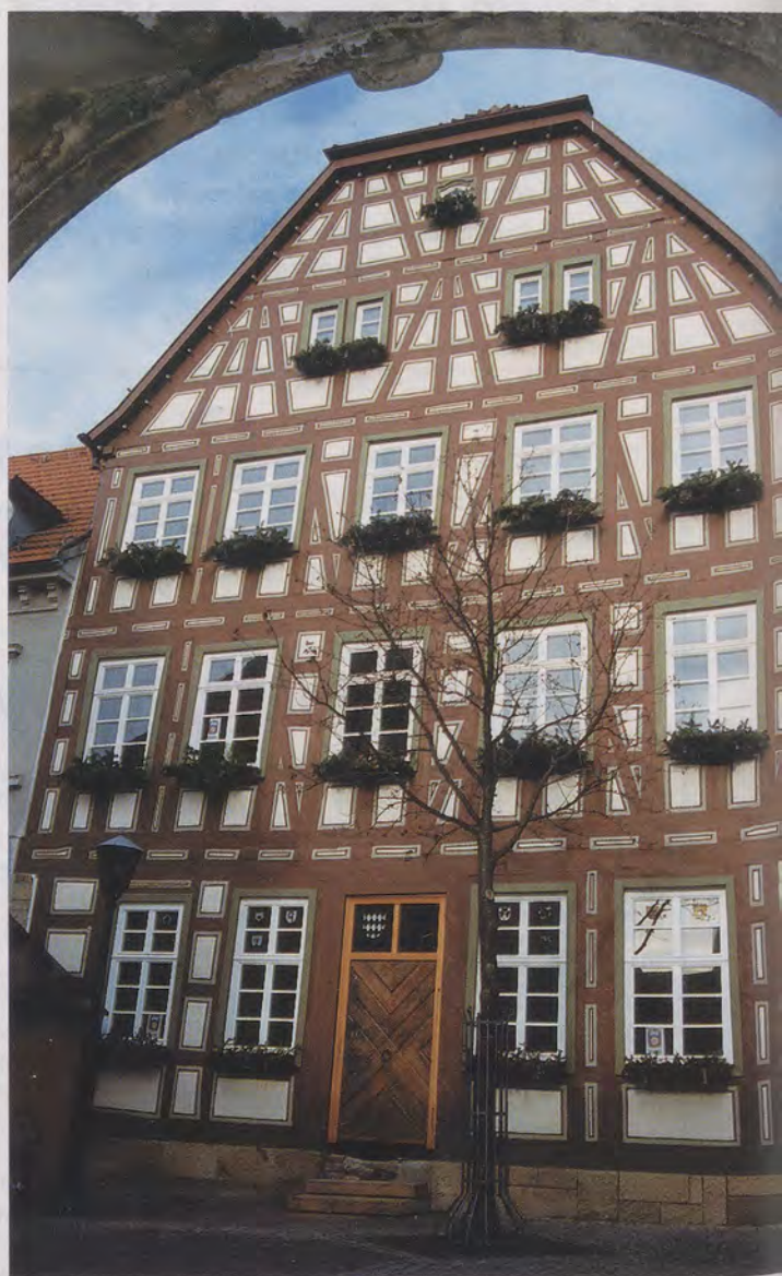
Das einst vom Einsturz bedrohte Gebäude ist mittlerweile der Stolz der Bürgerschaft: Der fertig sanierte Schweizer Hof in Bretten erstrahlt in neuem Glanz.
