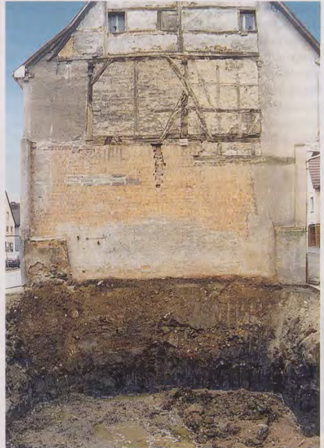
Nürtingen, Mönchstraße 21. Im linken unteren Gebäudeeck ist der Stadtmauerstumpf gut erkennbar. In der dunklen Schicht unter der Stadtmauer wurde Keramik aus dem 12. Jh. geborgen.
