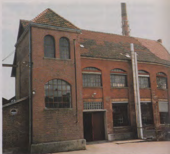
Fouquet-Werke in Rottenburg, aufgenommen vor drei Jahren. Bei «Fouquet und Frauz», früher der größte Betrieb in der Stadt, wurde am 18. November 1918 ein Arbeiterrat gewählt.
