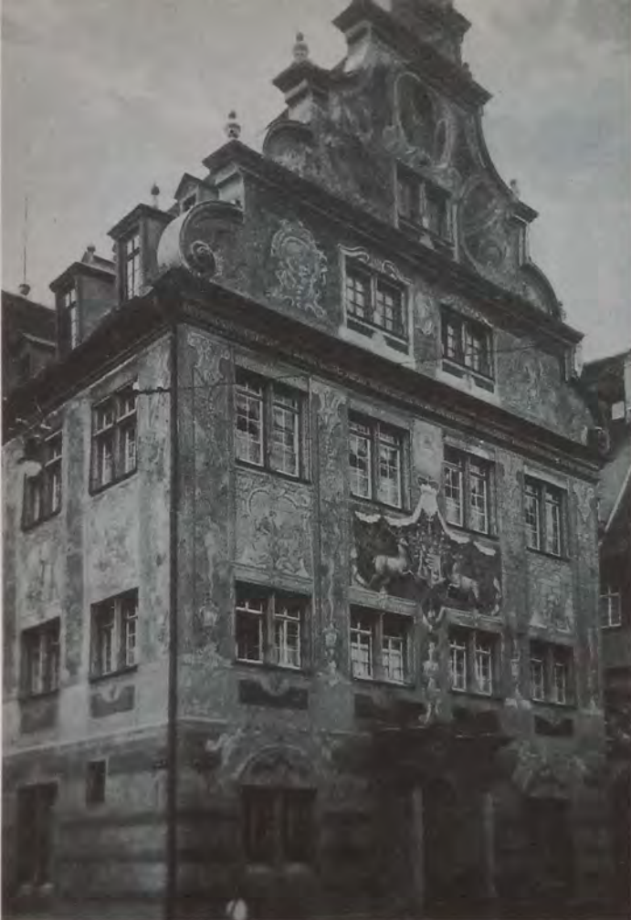
Das sogenannte Ständehaus in der Calwerstraße in Stuttgart. In dem bekannten Halbmondsaal tagte der württembergische Landtag, im November 1918 versammelten sich hier die Arbeiter- und Soldatenräte. Das Gebäude wurde 1944 zerstört.
