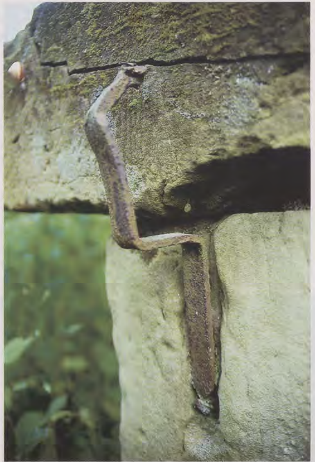
Eine eiserne Klammer an einer defekten steinernen Ruhebänk: Sie sollte einst den Sturzstein fest auf den Pfeilern halten, doch der Sturzstein brach. Gut sichtbar ist die mit Widerhaken versehene geschmiedete Verankerung (oben), die einst, von Blei umgeben, auch im oberen Stein festsass. Unten ist die Befestigung noch einigermaßen intakt.
