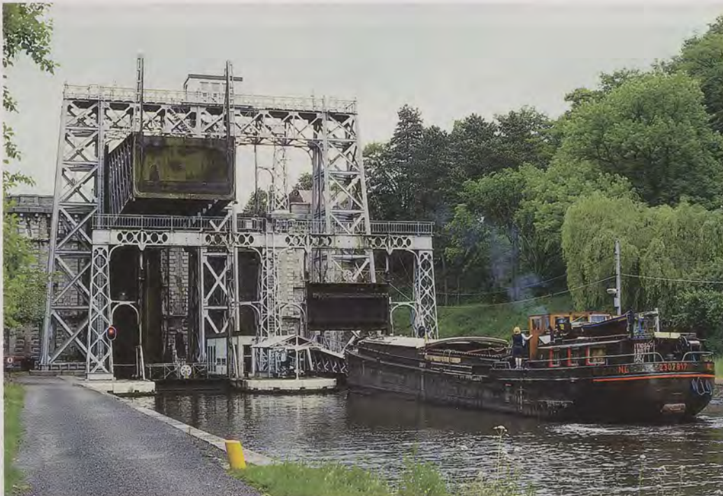
Oben rechts: Beim belgischen Ort Ronquières steht dieses Schiffshebewerk, das auf einer schiefen Ebene in zwei Trögen Binnenschiffe bis zu 1350 t um 58 Meter hebt oder herablässt. Noch größere Anlagen hatte Otto Konz 1938 bei Plochingen und Göppingen vorgesehen.
