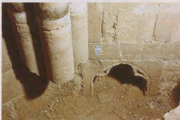
Sakramentsnische mit Blendmaßwerk, Sondage im Wandfeld östlich des Sakristei-Anbaus.
