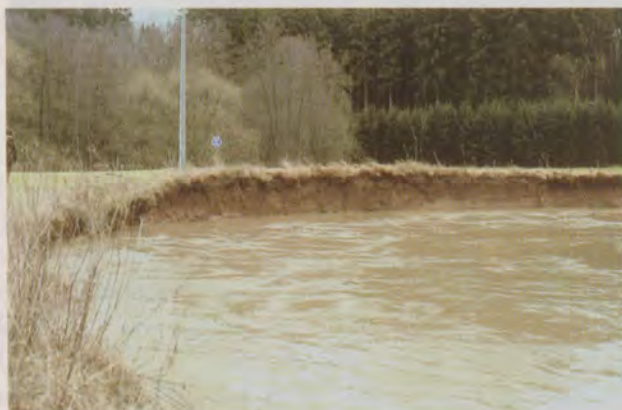
Die Lein darf auf dem Gelände des NABU bei Hochwasser an den Ufern «nagen».
