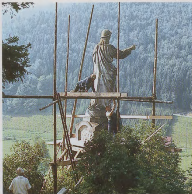
Restaurierung des «Guten Hirten» oberhalb von Hütten.
