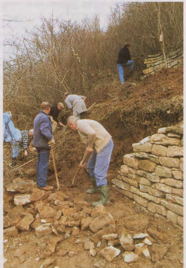
Steinheimer Albvereinsmitglieder reparieren Trockenmauern am «Burgberg».
