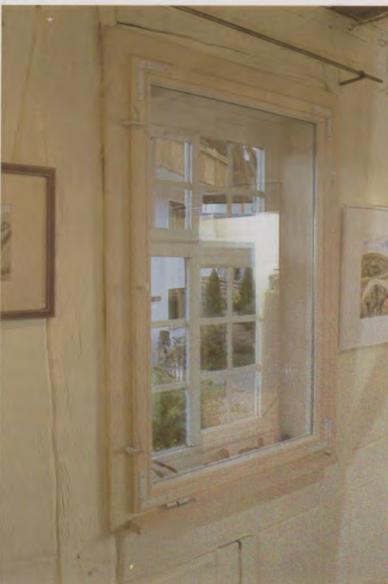
Fenster mit originalem Einfachfenster außen und Einscheibenfenster innen.
