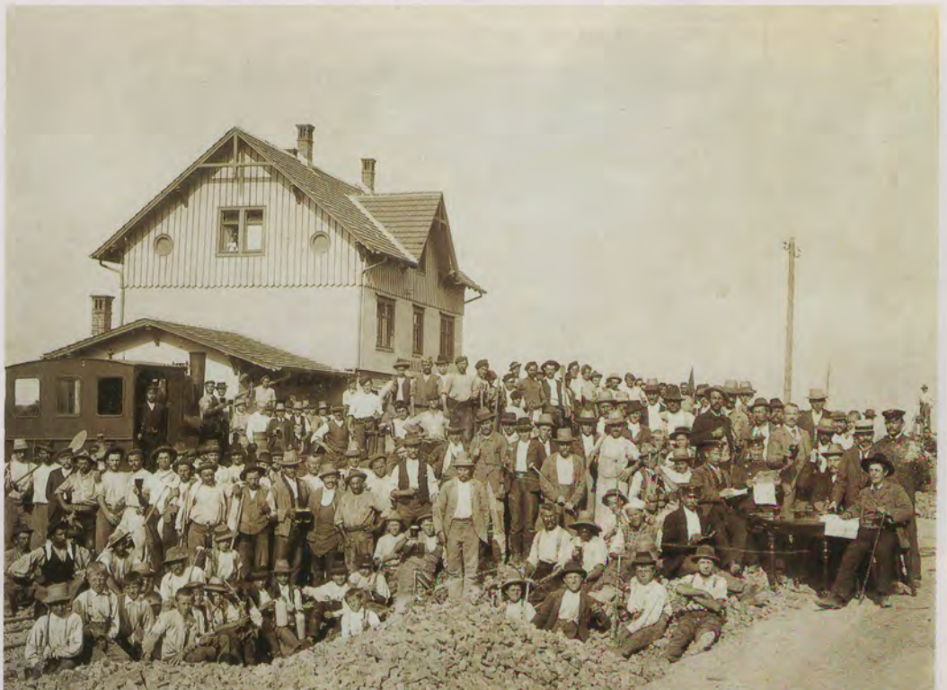
Im Jahr 1902 wurde die bis dahin als Schmalspurbahn betriebene Filderbahn auf Normalspur ausgebaut. Bahnhof Bernhausen mit Eisenbahnbauarbeitern.
