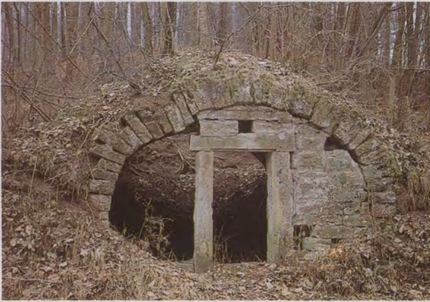
Auch dieser Unterstand im Stromberg wurde «in letzter Minute» saniert; das Gewölbe war an einer Stelle bereits eingedrückt.
