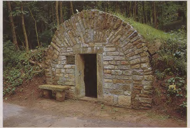
Auch dieser Unterstand im Stromberg wurde «in letzter Minute» saniert; das Gewölbe war an einer Stelle bereits eingedrückt.
