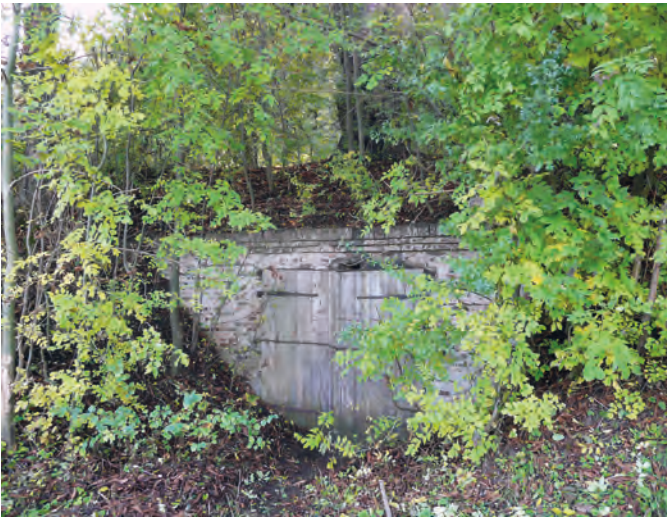
Der ehemalige Eiskeller hinter der unscheinbaren Tür ist heute ein wichtiges Fledermausquartier.
