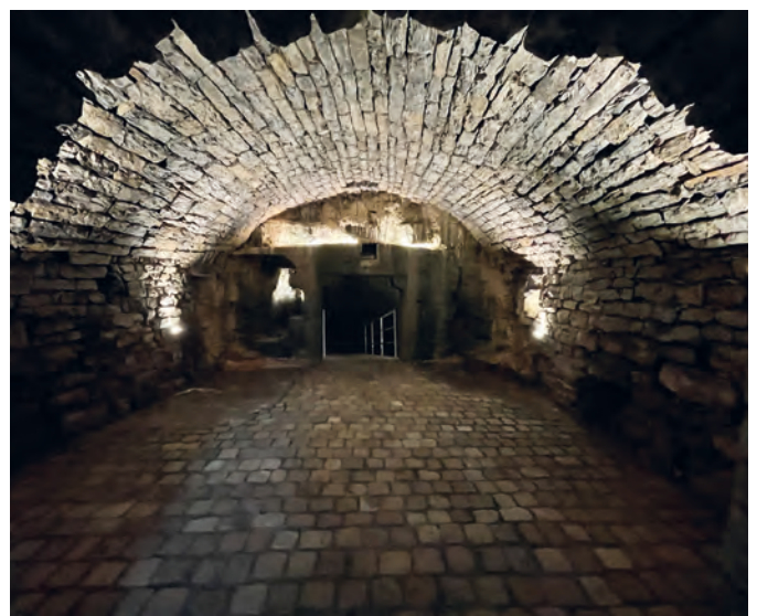
Nach einem halben Jahr Arbeit mit Ausräumen und notwendigen Reparaturen an Gewölbe und Mauern präsentiert sich der Keller mit einem ebenen Boden aus historischem Granitpflaster und LED-Beleuchtung.
