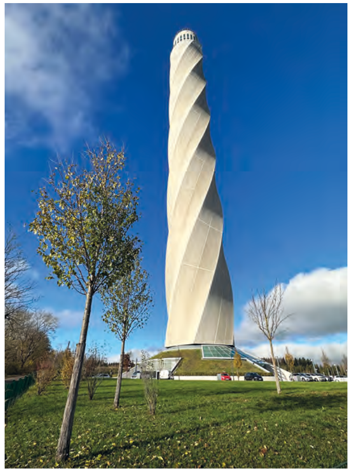
Der 246 Meter hohe Thyssen-Krupp-Elevator-Testturm ist der weltweit zweithöchste Testturm für Aufzugsanlagen und seine Besucherplattform die höchste in Deutschland.
