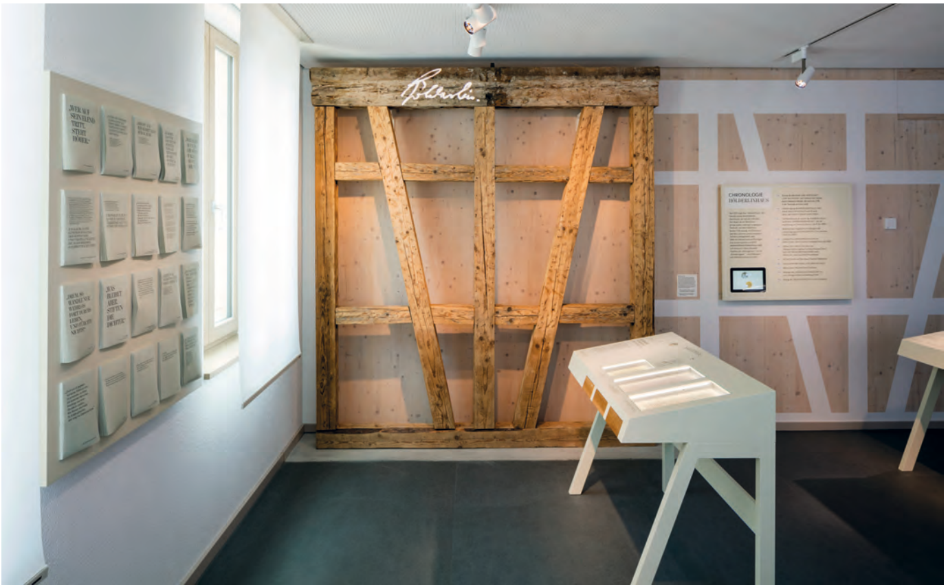
Eine freigelegte Fachwerkwand mit Balken aus verschiedenen Epochen. Die Blätter mit den Hölderlin-Sentenzen sind zum Mitnehmen.
