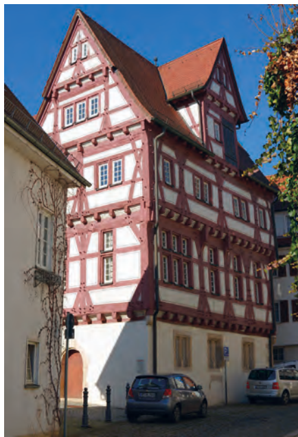
Querbau in der Mönchstraße – die stadtzugewandte Schauseite
