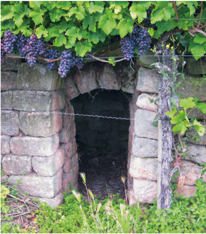
In den Fels gemauerte Weinbergunterstände, wie hier in Esslingen am Neckar, prägen viele der steilen Terrassenweinberge unserer Kulturlandschaften bis heute.
