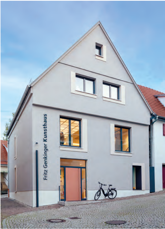
Das Fritz Genkinger Kunsthaus, erbaut von Manfred Knappe, fügt sich in Kubatur und äußerer Gestalt nahtlos in die städtebauliche Struktur der Marbacher Altstadt ein.
