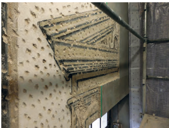
Wiederentdeckte Dekoration aus der Bauzeit in der Martinskirche von Montbéliard vor der Restaurierung
