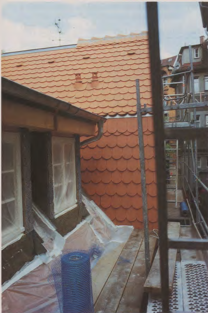
Weberstraße 2: Zwei neue Gauben nach Süden und das neu eingedeckte Dach mit Mansarde.
