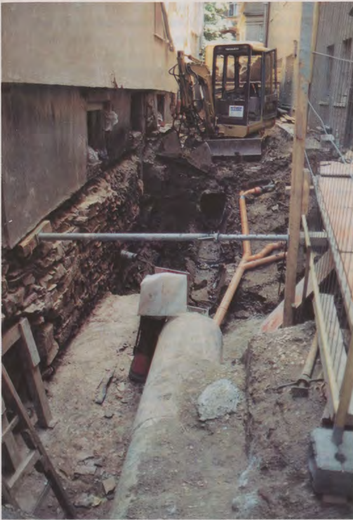
Richtstraße: Links die Untergeschoßwand aus Natursteinen, bereits teilweise mit neuer Betonmauer.
