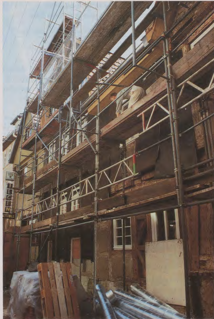
Weberstraße 2: Die Außenfassade wird verputzt – hier die Vorbereitungen.
