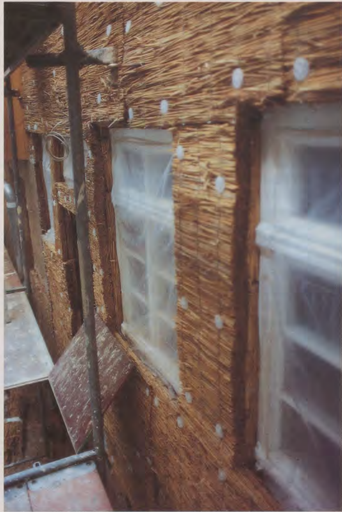
Weberstraße 2: Ökologisch besonders wertvoll – Schilfrohmatten zur Dämmung.
