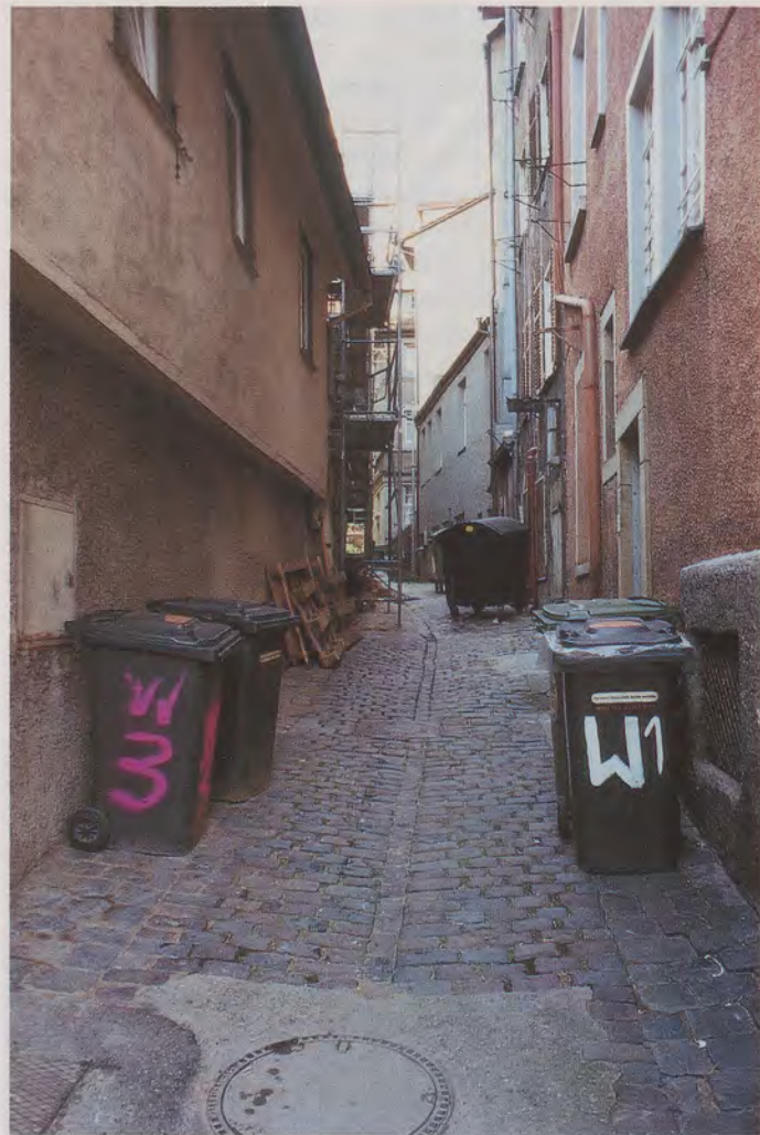
Richtstraße: In dieser Straße liegt ein unzulänglicher städtischer Kanal.
