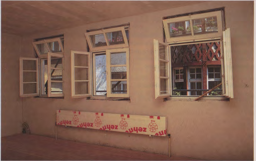
Weberstraße 2: Die Innenausbauarbeiten gehen voran. Futter und Bekleidungen an den Fenstern fehlen noch.
