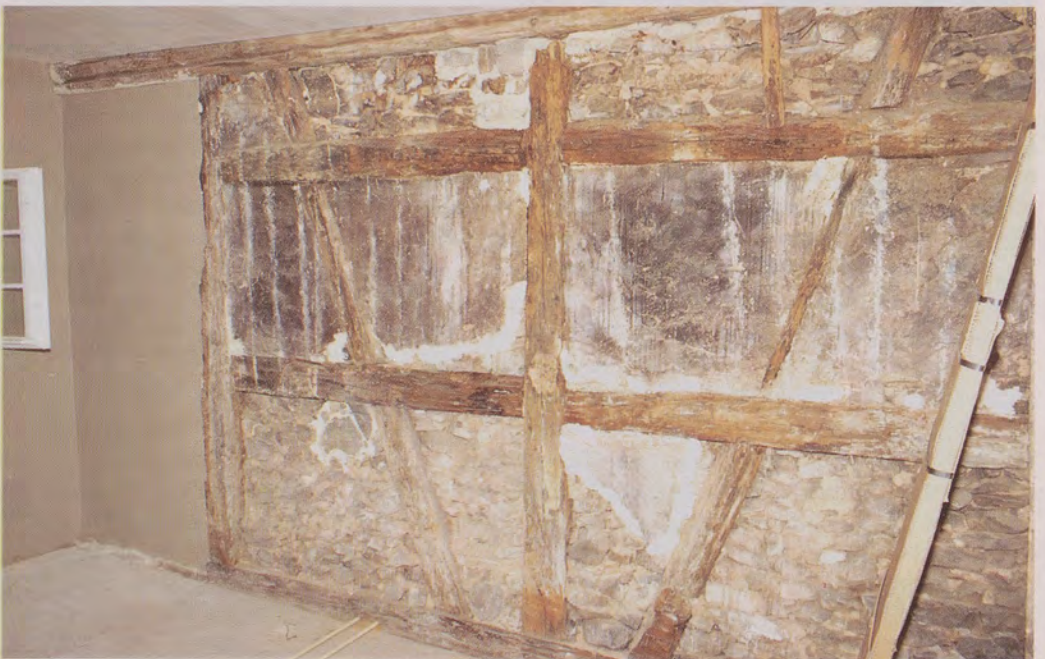
Weberstraße 2: Die Wand mit Fachwerk und verschiedenen Gefachausfüllungen wird noch restauriert und bleibt so sichtbar.
