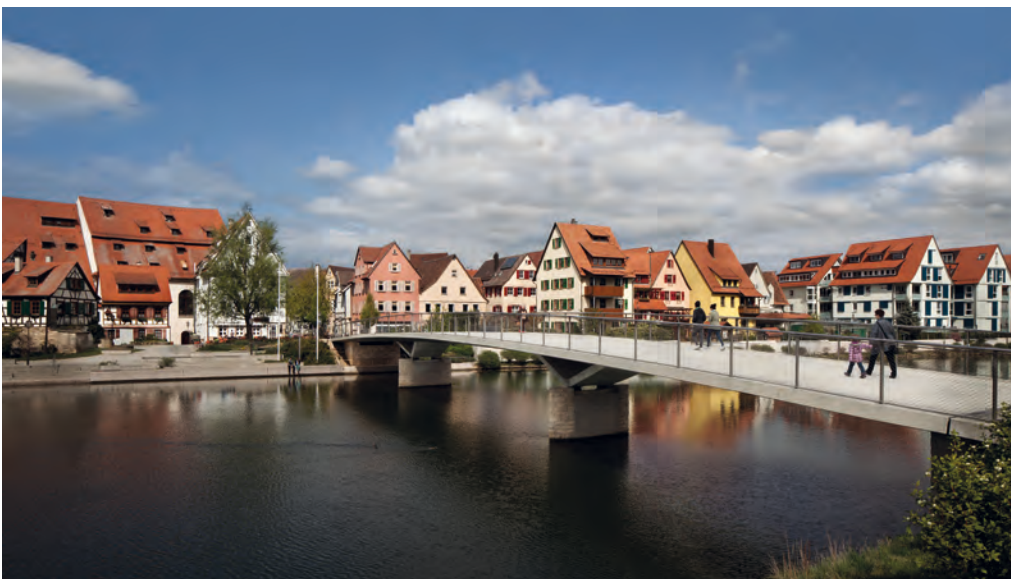
Die Josef-Eberle-Brücke in Rottenburg, benannt nach dem Rottenburger Dichter und Gründer der Stuttgarter Zeitung , ist eine der vielen Fußgänger- und Fahrradbrücken, die Werner Sobek gebaut hat: Wie Jörg Schlaich, sein Vorgänger an der Universität Stuttgart, baut er möglichst leicht und elegant, auch um Material zu sparen.
