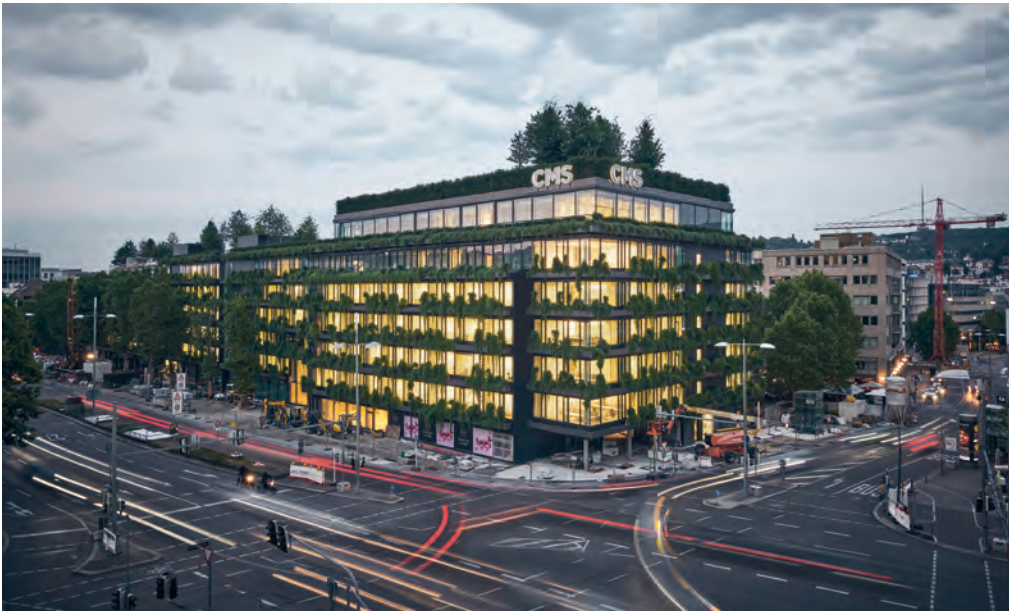
Die begrünten Fassaden und Dächer des Neubaus um die Calwer Passage in Stuttgart von Christoph Ingenhoven hat das Büro von Werner Sobek geplant. Die Pflanzen setzen 90 Prozent der Sonnenenergie, die auf das Gebäude einstrahlt, in Verdunstungskühle um.
