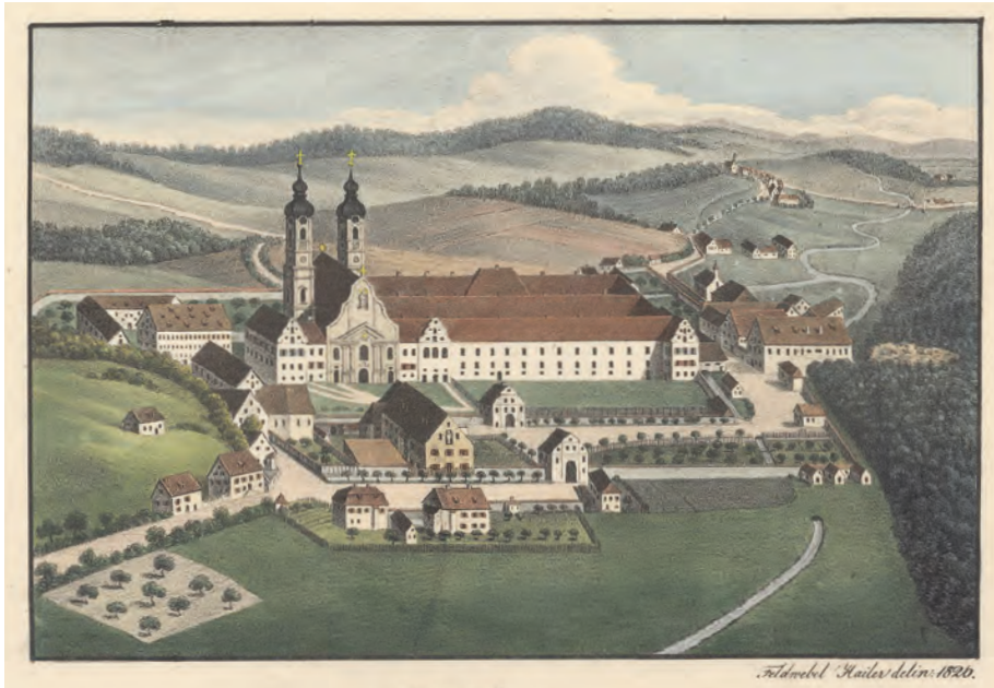
Die kolorierte Lithographie des Feldwebels Hailer aus dem Jahr 1826 zeigt die Klosteranlage von Westen. Das Gebäude des ehemaligen Priorats liegt an der Südostecke, sichtbar ist nur der Giebel am rechten Ende des hinteren Flügels.
