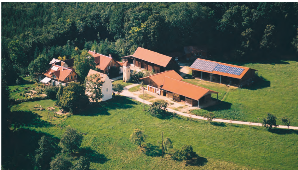
Die Hofanlage Loretto heute. Von rechts nach links: die modernen Stall- und Scheunengebäude, der massive Stadel und das Traföhäuschen aus der Zeit der Heilanstalt, der Dreiseithof des 19. Jahrhunderts und der Kapellenbau aus der Klosterzeit.
