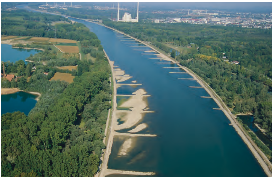
Der Rhein bei Rastatt. Der Fluss mit den Buhnen (Querriegeln) zur Verhinderung der Eintiefung. Beidseits des Rheins erstrecken sich Auewälder als Ergebnisse des Waldaufbaus. Im Hintergrund ein Kraftwerk am Rhein bei Karlsruhe.
