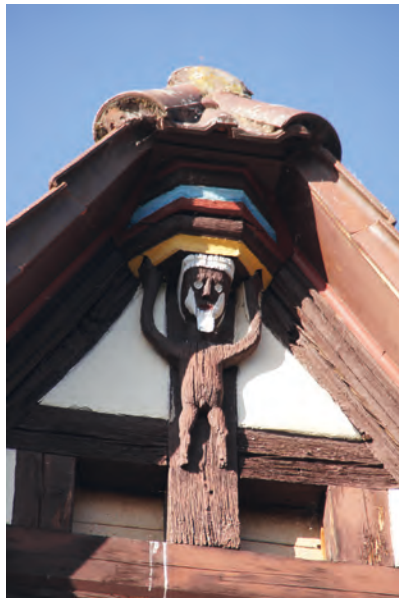
Das «Wassermändle» im Giebel soll vor Hochwassergefahren schützen.
