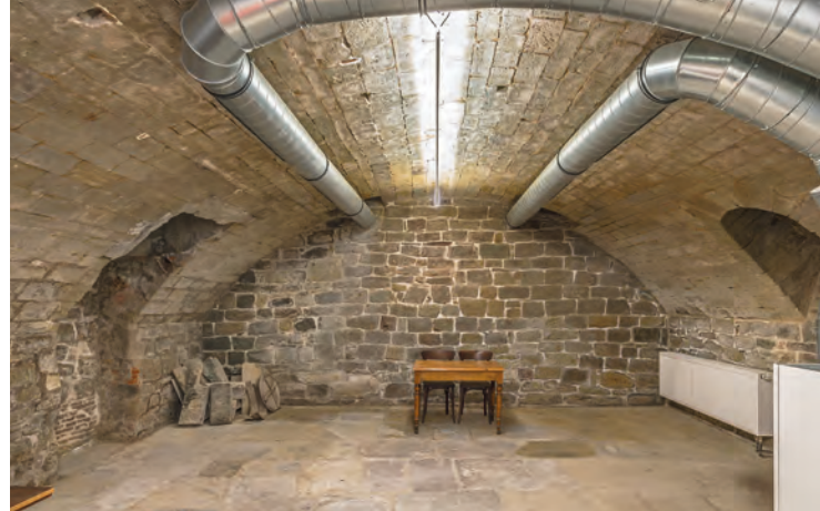
Wie das massive Erdgeschoss, so zeichnet sich auch der tonnen-gewölbte Keller durch sein qualitätvolles Mauerwerk aus.
