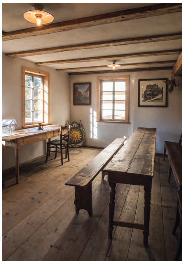
In der alten Wohnung im Obergeschoss: alter Boden, freigelegte Wände und Decken, wiederhergestellte Fenster und ein passender Fußboden aus alten Dielen.
