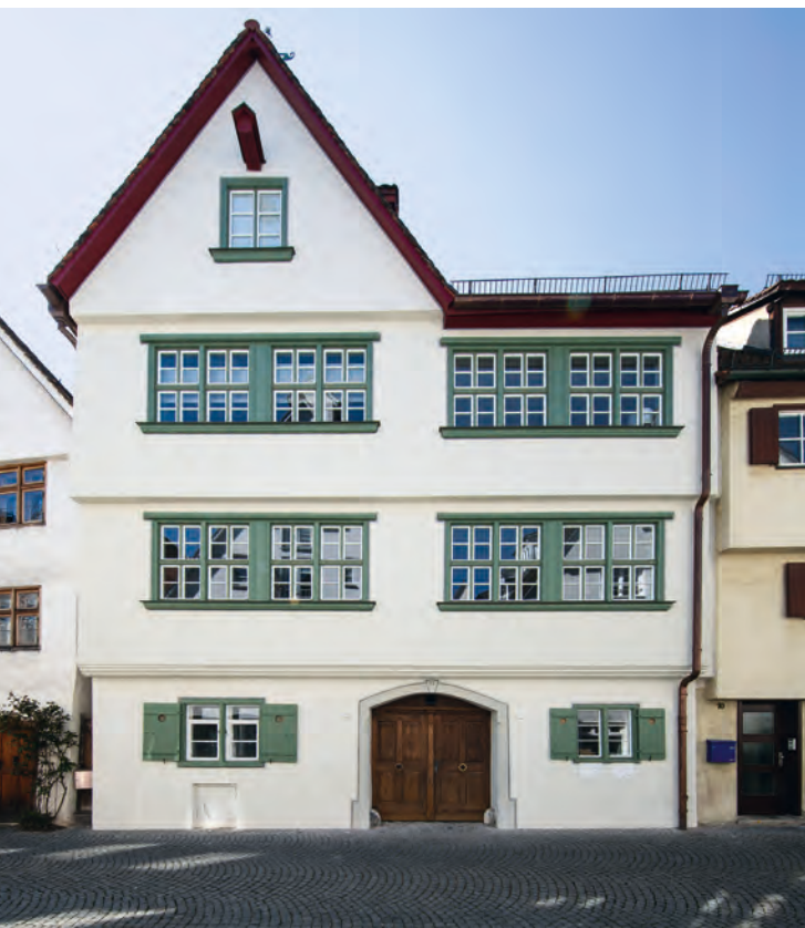
Nach Sanierung und Rekonstruktion der Bandfenster aus dem 18. Jahrhundert ist das Haus wieder ein Schmuckstück der Ulmer Altstadt.
