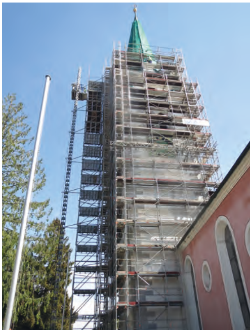
Eingüstet und das Dach mit grünem Fangnetz gesichert: der Turm der Sipplinger Pfarrkirche wird saniert.
