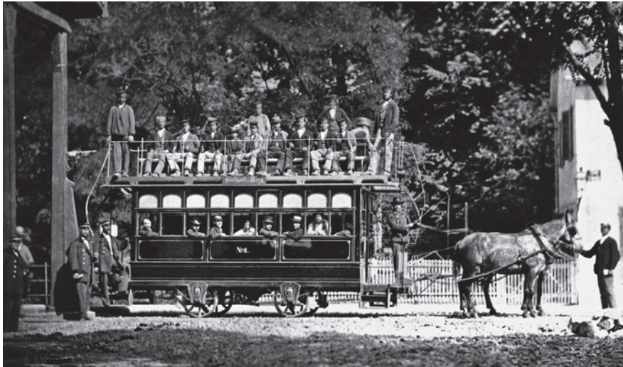
Decksitzwagen Nr. 6 der Maschinenfabrik Esslingen (1868) vor der offenen hölzernen Wagenhalle in Stuttgart-Berg. Die für den Fotografen posierenden «Fahrgäste» sind in diesem Fall wohl Arbeiter der Pferdebahngesellschaft. Die 55 Zentner schweren Fahrzeuge erforderten Doppelbespannung.
