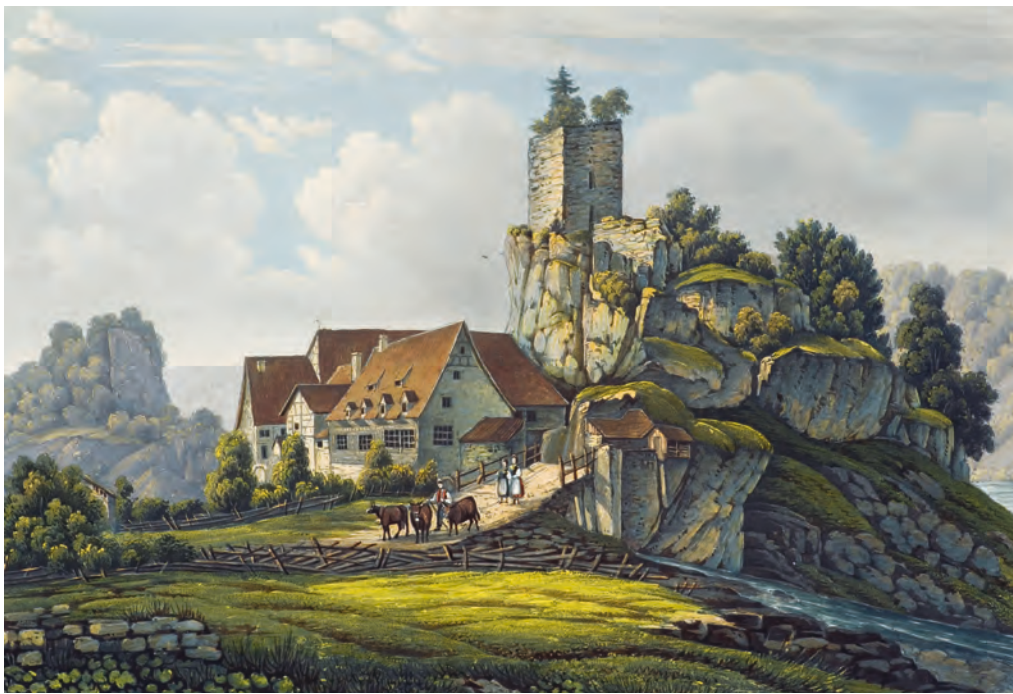
Die denkmalgerechte Sicherung und Sanierung des dendrochronologisch mittlerweile in die Mitte des 14. Jahrhunderts datierten Bergfrieds der Burg ruine Dietfurt – hier in einer kolorierten Aquatinta von Johann Weber d.Ä. aus dem Jahr 1835 (16,4 x 24,3 cm) – wurde in den vergangenen Jahren von der DRK-Bergwacht Sigmaringen als Eigentümerin der Anlage ausgeführt.
