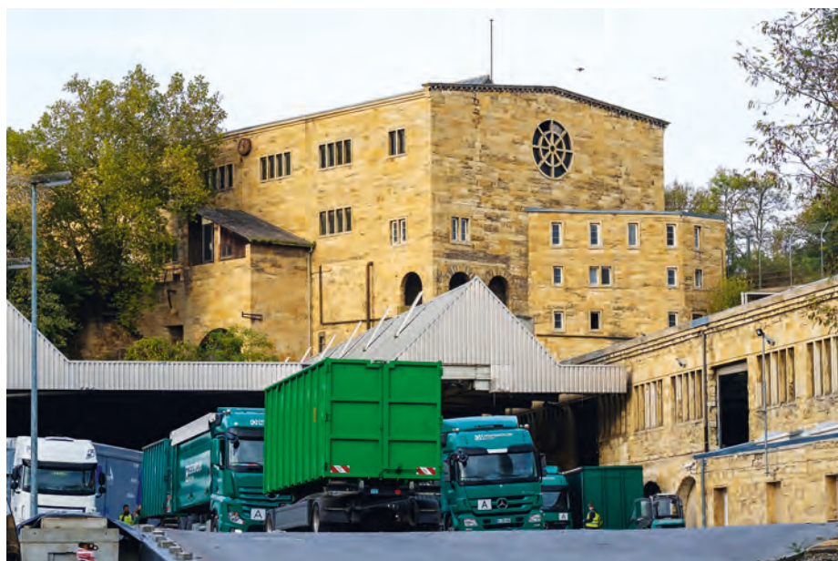
Die zwei riesigen Hallen, die «Vierkranhalle» rechts und die «Versandhalle» oben, stammen aus den 1920er-Jahren. Sie stehen unter Denkmalschutz, ebenso wie die Fabrikantenvilla gleich gegenüber.
