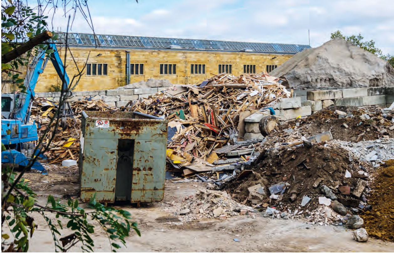
Der Entsorgungsbetrieb auf dem Lauster-Areal befindet sich bereits in vollem Gang. Wer kann wirklich kontrollieren, ob sich im Bauschutt, neben einem gelegentlichen Autoauspuff wie hier, nicht auch Gefahrenstoffe befinden?
