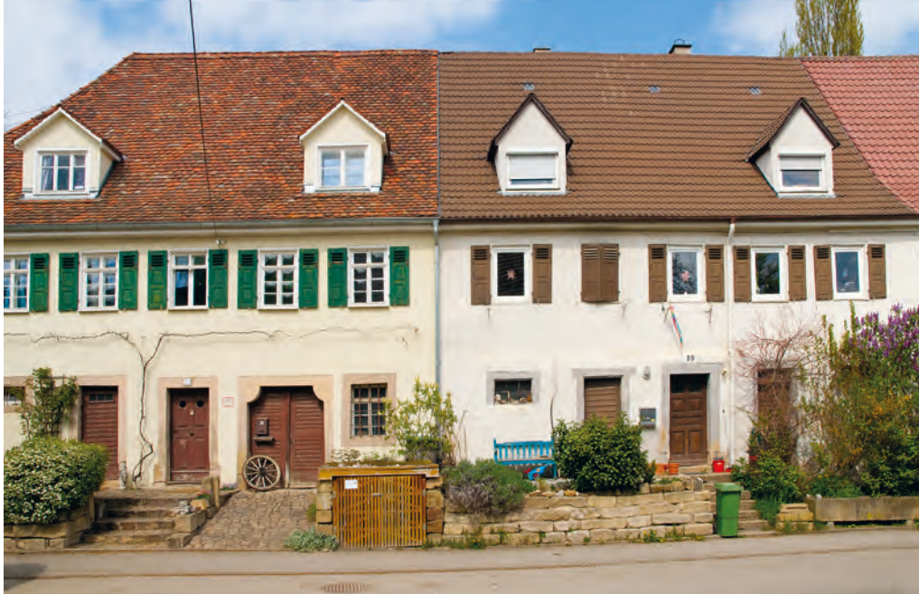
Das Doppelhaus Heerstraße 20/22 in Wankheim wurde 1786 von der Wankheimer Ortsherrschaft zur Unterbringung der Juden errichtet.
