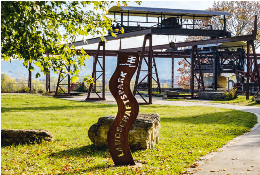
Der 2010 und 2014 in zwei Abschnitten eröffnete «Travertinpark» – hier die Krananlagen des Steinbruchs Schaufele – ist ein einzigartiges Natur- und Technikenkmal. Er bleibt ohne das Lauster-Areal allerdings Stückwerk.
