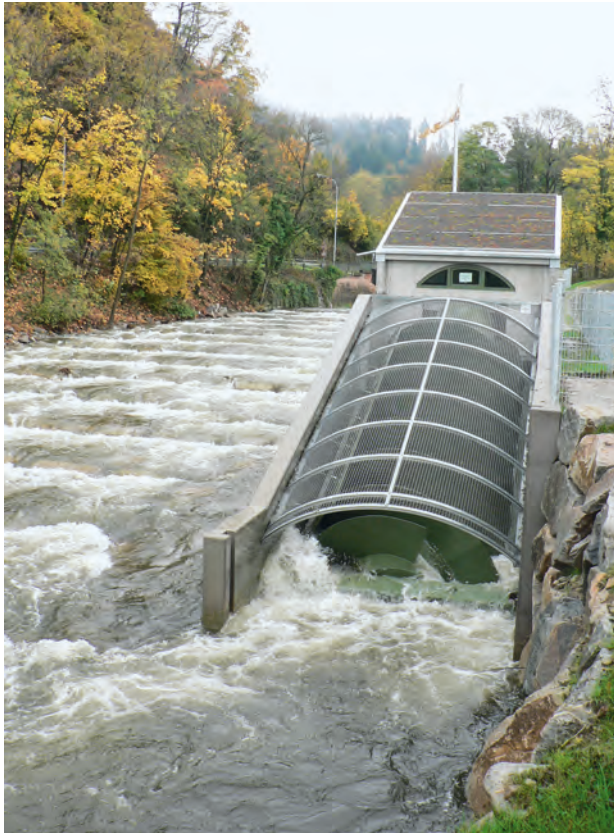
Innovatives Wasserkraftwerk an der Dreisam.
