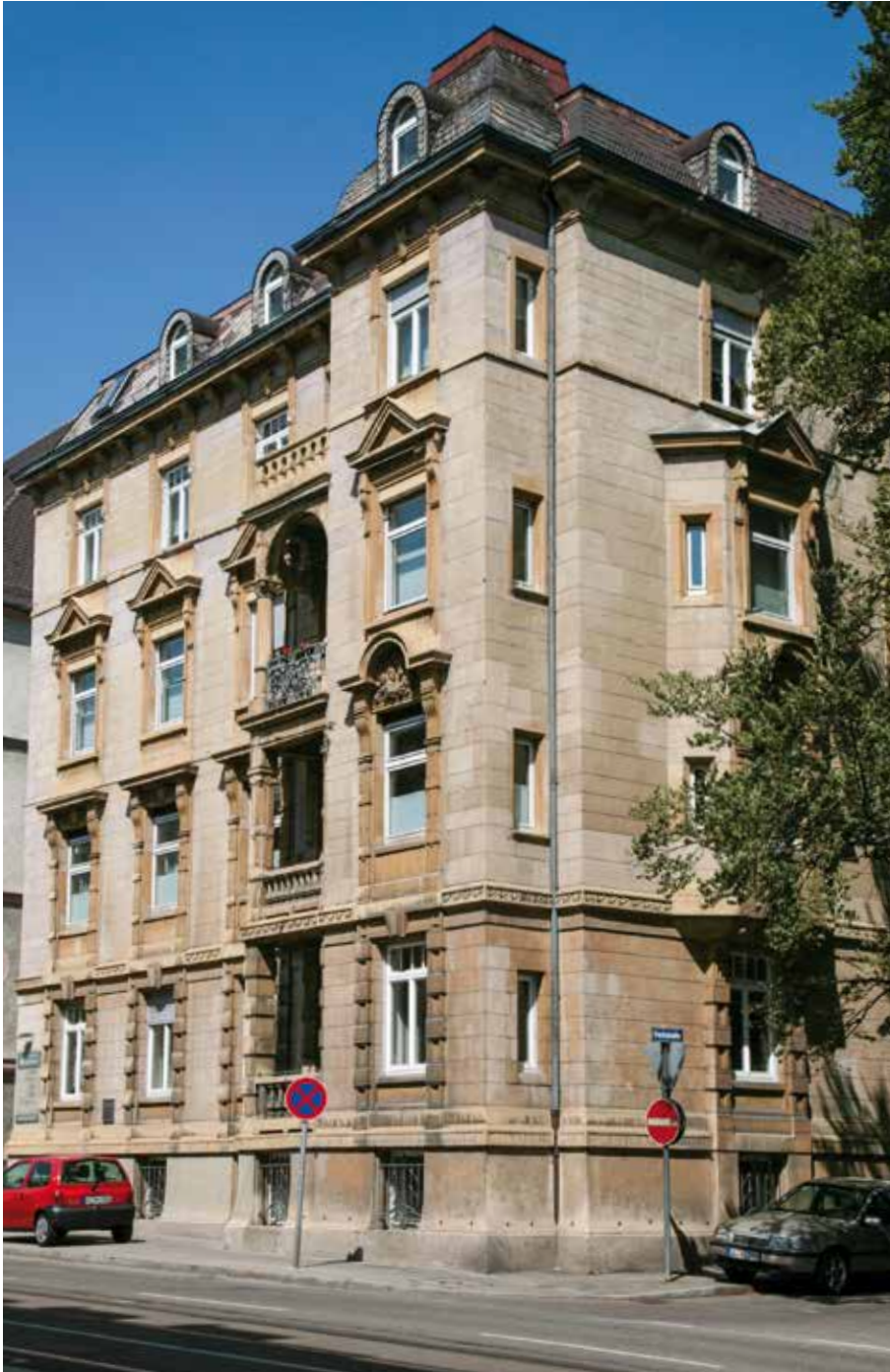
Abb. 2 - Im Haus Olgastraße Nr. 139 (ehemals Nr. 81) wohnte die Familie Scholl in den Jahren 1933-1938 im ersten Stock; heutiger Zustand (StadtA Ulm).
