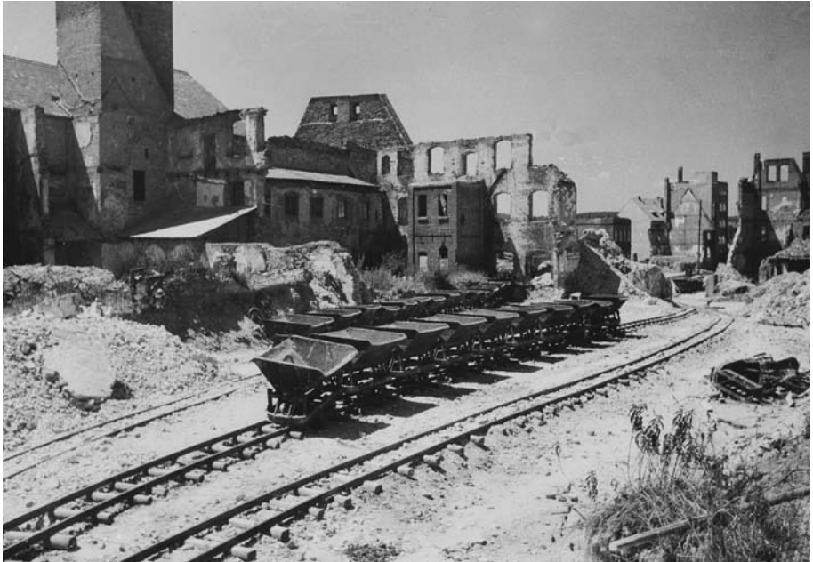
Abb. 5 - Blick auf die Wengenkirche und die Klostergebäude mit Loren zum Schuttabfahren im Vordergrund (StadtA Ulm).
