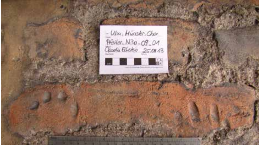
Abb. 15 - Backstein des Münsterchores (Ende 14. Jahrhundert); die Fingerabdrücke stammen vom Wendeprozess der Steine während der Trocknungsphase (Foto: Claudia Eckstein).
