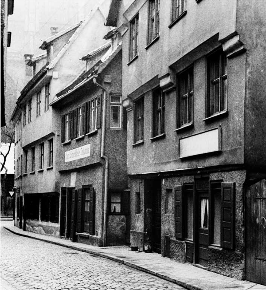
Abb. 8 - Blick in die Rabengasse nach Süden Richtung Ulmer Münster auf das ehemalige Horstsche Haus, Rabengasse 3, das kleinere Gebäude in der Mitte. Die helle Gedenktafel befindet sich über der Eingangstür unter dem größeren Firmenschild. Die Saurische Druckerei, Rabengasse 6, lag auf der anderen Straßenseite schräg gegenüber, links außerhalb des Bildes (StadtA Ulm).
