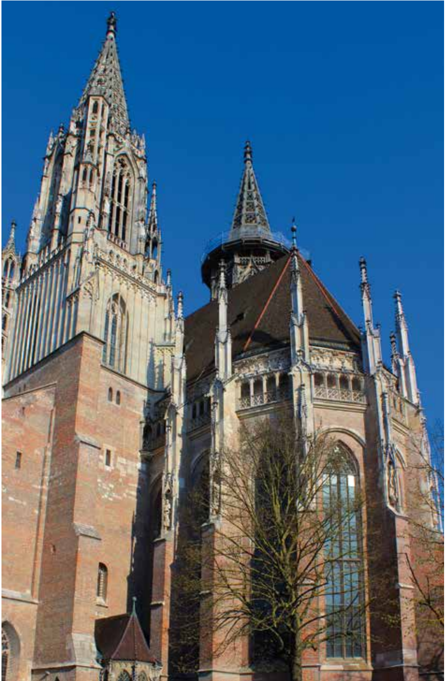
Abb. 4 - Chor des Ulmer Münsters von Süden; nach der Restaurierung und Reinigung (2012-2014) ist das Baumaterial Backstein deutlich erkennbar (Foto: Claudia Eckstein).
