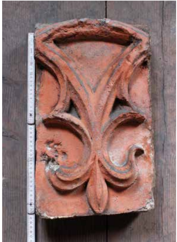
Abb. 5 - Backstein mit Lilienrelief, rot überfasst; die Maße betragen etwa 42 x 24 x 7 cm. Der eingetiefte Abdruck auf der linken Seite stammt vermutlich von einem Tier, das während der Trocknung über den Stein lief (Museum Ulm. Foto: Claudia Eckstein).
