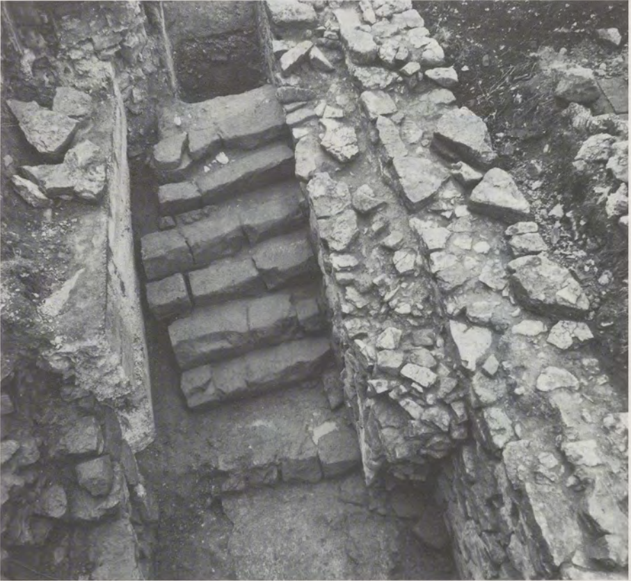
Abb. 4 Treppenabgang vom nördlichen Seitenschiff in die Krypta.
