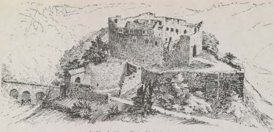
Leofels. Ansicht von Norden (idealer Standpunkt).
