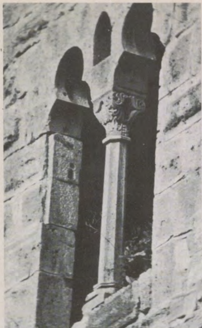
Fenster an der Außenseite des Palas
