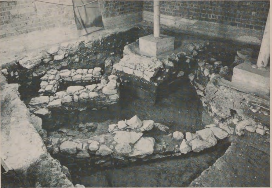
Tafel 5/1. Unterreggenbach — Profan-Bereich D — ehemaliger Pfarrhof — hochmittelalterlicher Steinbau von Norden.
