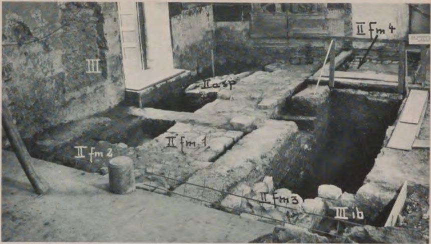
Tafel 3/1. Niederstetten, St. Jakob. Grabung von SW.
