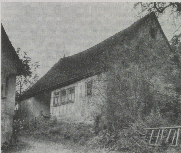
Das Spital in seinem heutigen Zustand.
