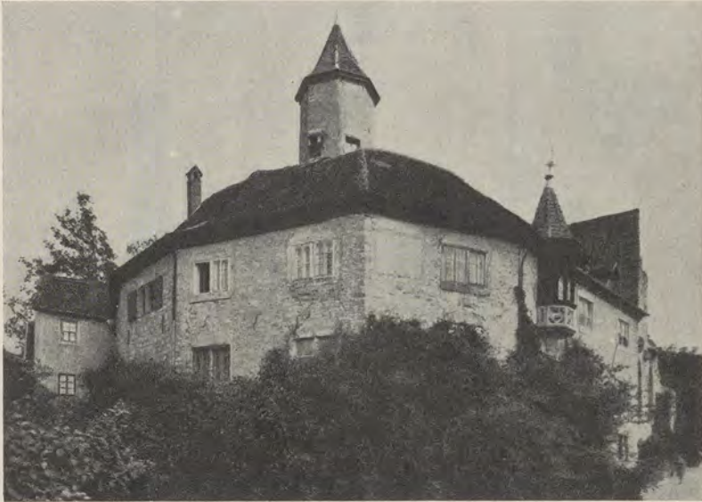
Abb. 14. Burg Krauthcim. Schloß mit Treppenturm von Südwesten.
