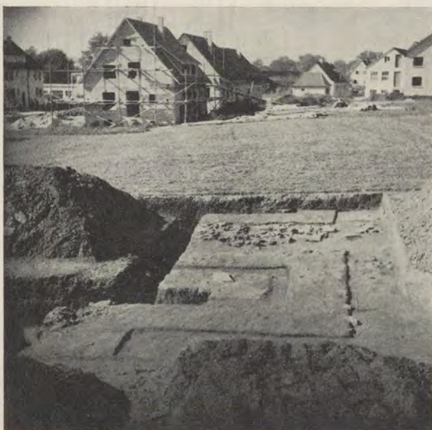
Abb. 5. Rendelkastell Öhringen. Fundamente der südlichen Tortürme in der 2. Bauperiode mit der zwischen beiden liegenden Stückung des Weges. Blick nach Westen.
